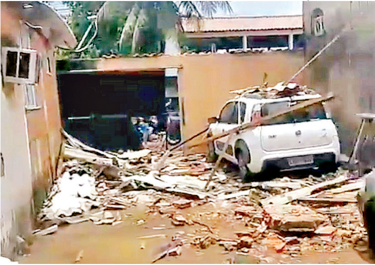
Com a força da água, ruas e casas da região ficaram alagadas
