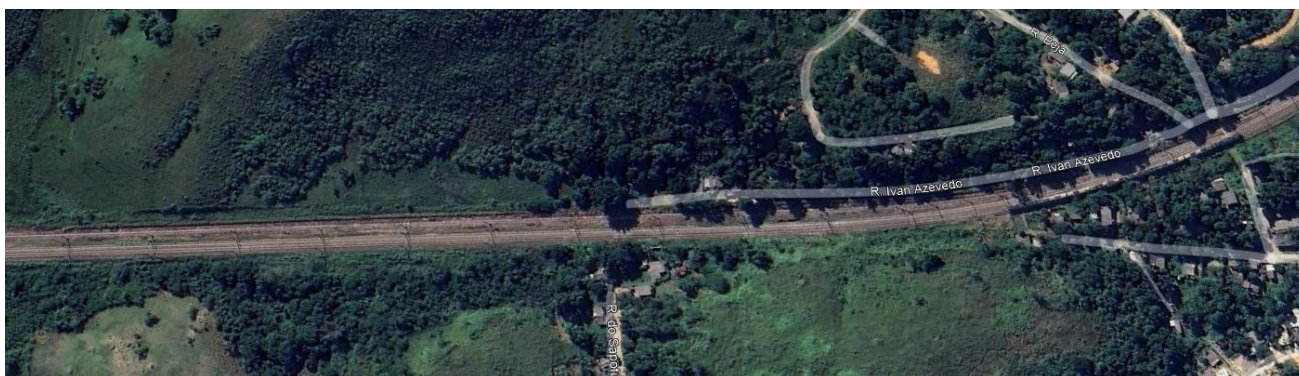
Ramal Japeri, superior Engenheiro Pedreira.
