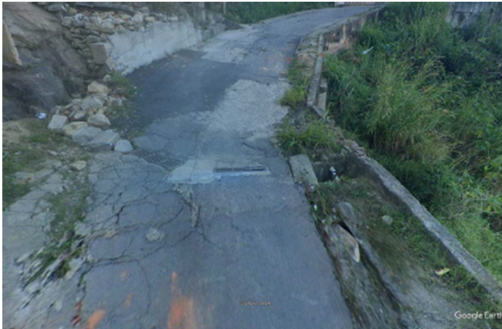
Figura 05: Fotografia da área de intervenção
