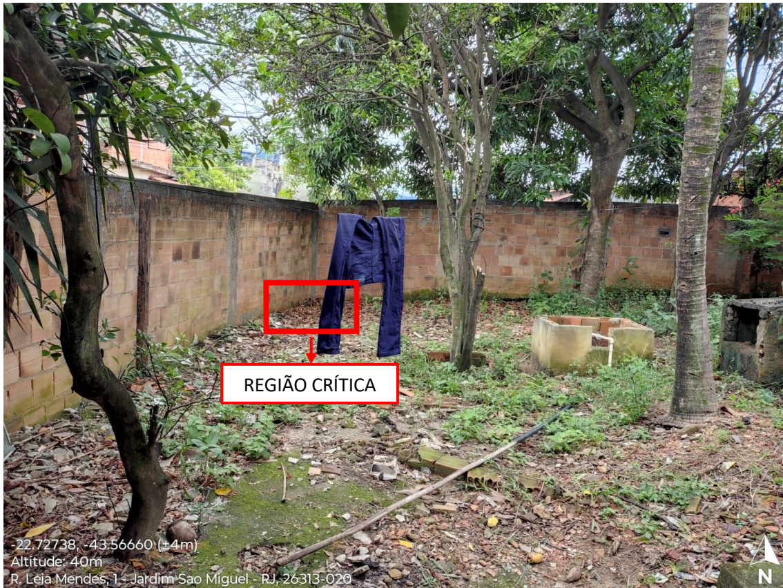
Figura 10 - Perspectiva Interna do muro
