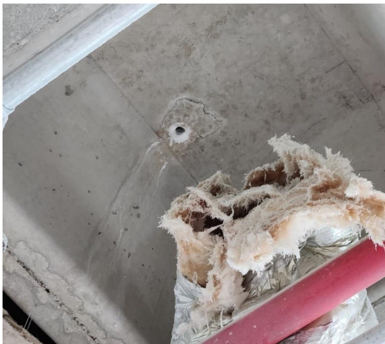
Figura 15: Furo a ser fechado no 4º Pavimento
