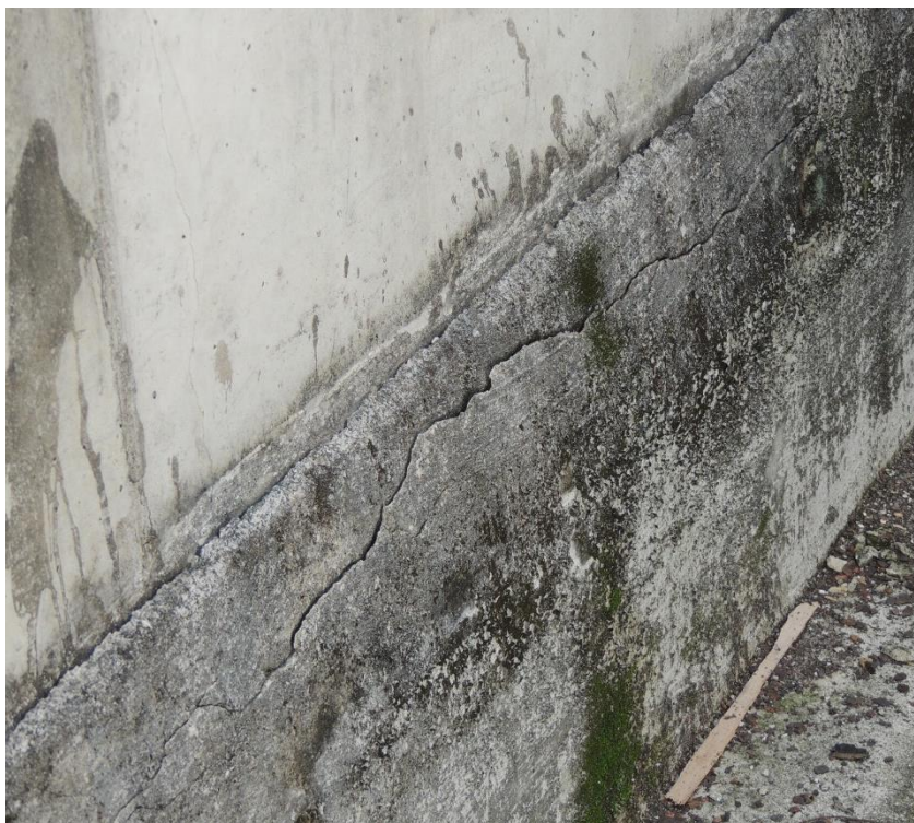
Figura 10: Deslocamento no pavimento de Cobertura
