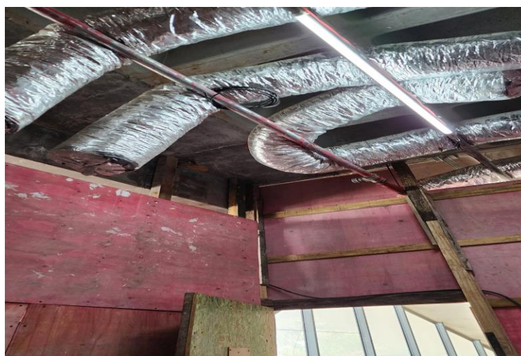
Figura 17: Demonstração da Patologia da Tubulação de aço galvanizado de 32 mm – 2º Subsolo
