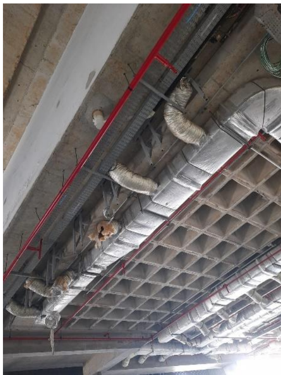
Figura 91: Demonstração da Patologia do Duto flexível de Ø 250 mm
