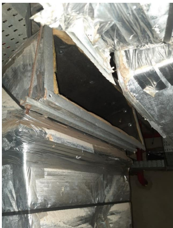
Figura 80: Demonstração da Patologia do Suporte com perfilado 38 mm x 19 mm
