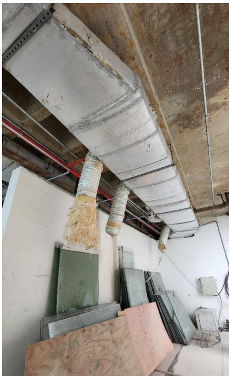
Figura 91: Demonstração da Patologia do Duto flexível de Ø 250 mm
