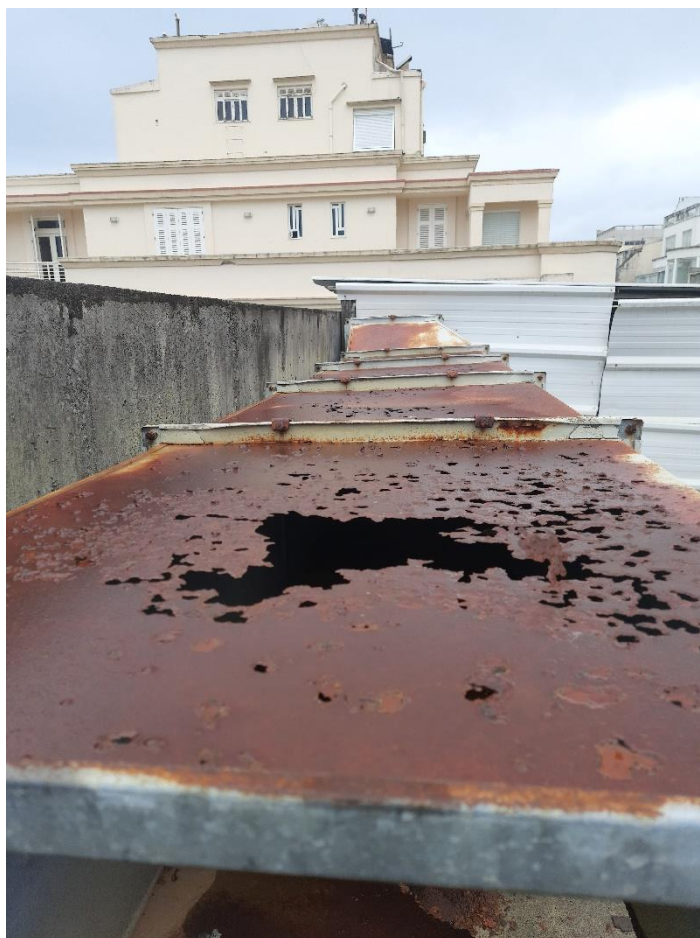
Figura 63: Demonstração da Patologia do Duto chapa galvanizada #22 – 7º Pavimento
