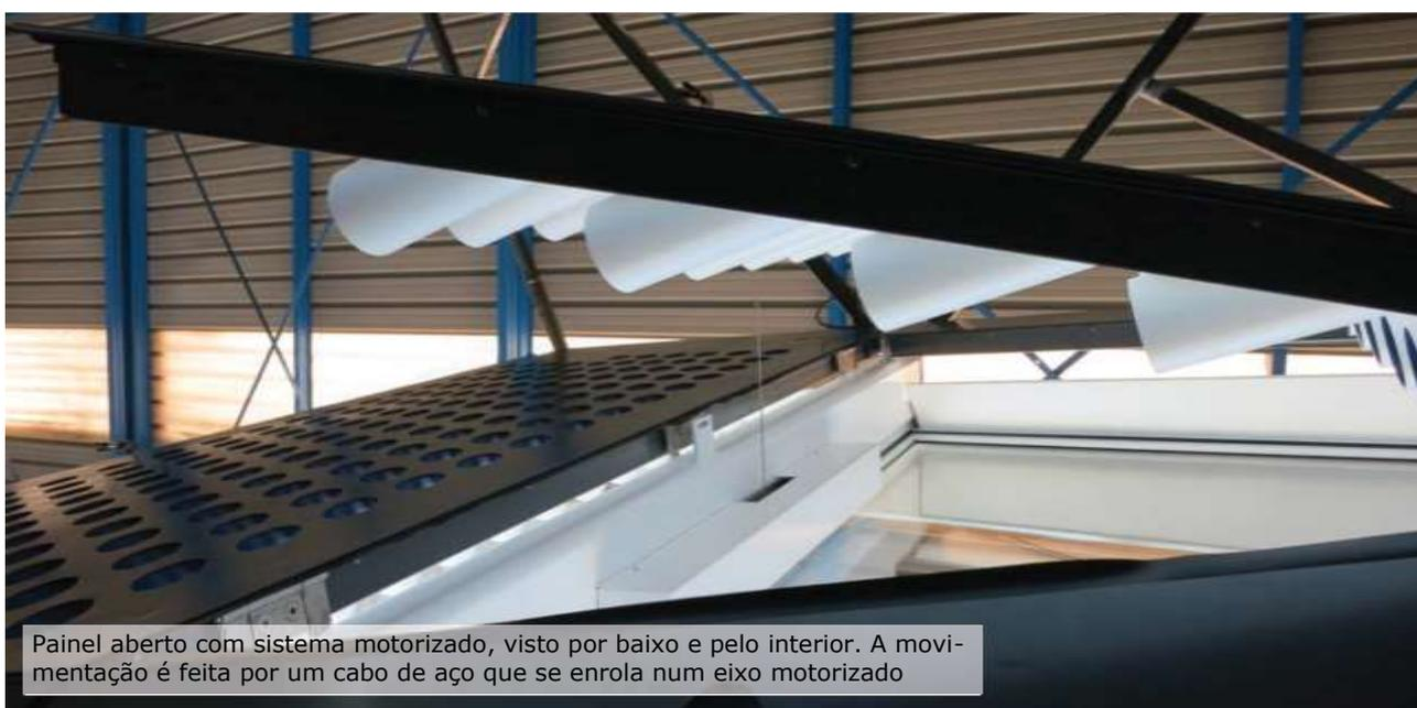
Painel aberto com sistema motorizado, visto por baixo e pelo interior. A movimentação é feita por um cabo de aço que se enrola num eixo motorizado
