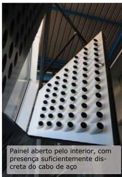
Painel aberto pelo interior, com presença suficientemente discreta do cabo de aço
