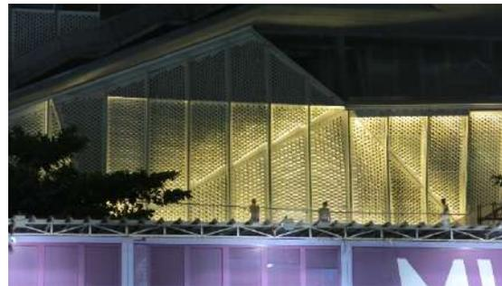
Painel cobogó iluminado (teste de iluminação)
