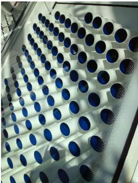
Detalhe externo do painel cobogó
