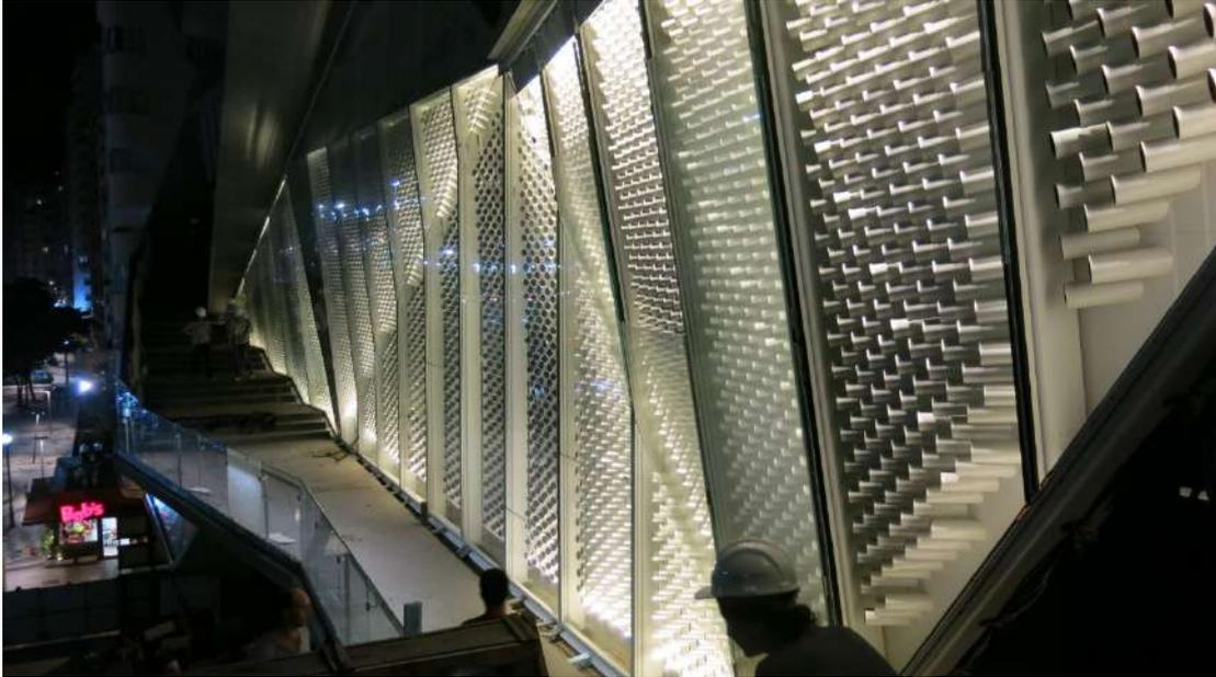
Painel cobogó iluminado (teste de iluminação)
