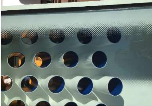
Detalhe vista externa painel cobogó com acabamento de borda do vidro
