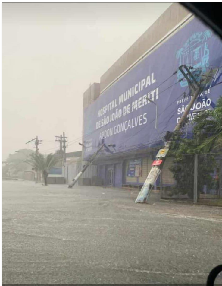
Figura 4 – Queda de postes sobre a fachada do Hospital Municipal de São João de Meriti no bairro de Vilar dos Teles.
