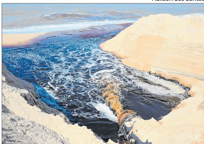
Abertura do extravasor na Lagoa do Piripiri
