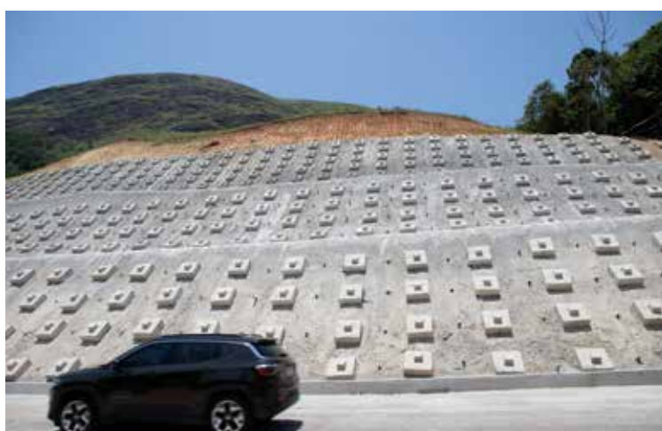
Contenção de encostas na Serra do Mato Grosso
