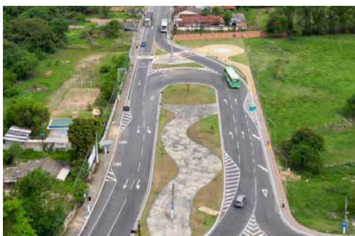
Acesso Leste, em Porto Real
