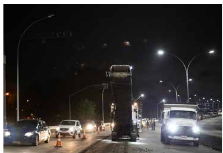
Obras de recuperação da Linha Vermelha
