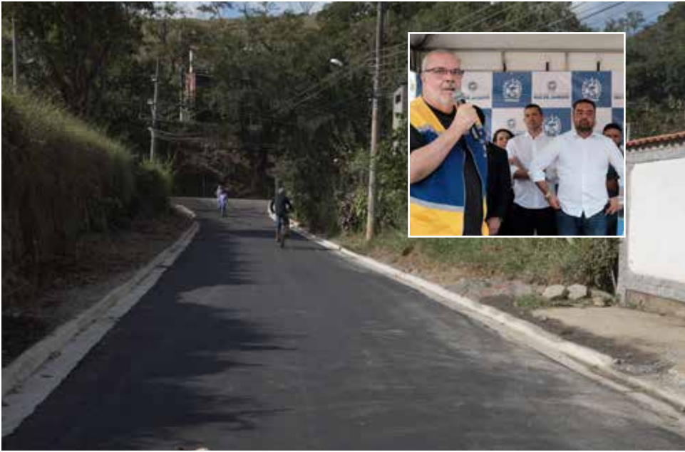
Entrega de obras de pavimentação em Valença
