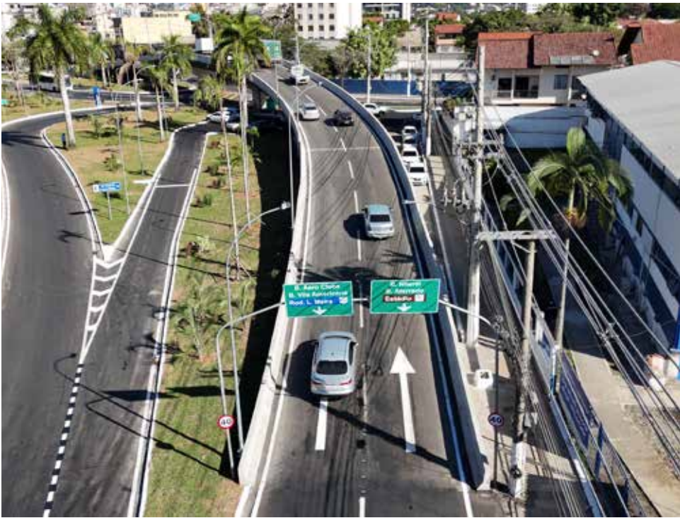
Viaduto Porfírio Almeida - Volta Redonda
