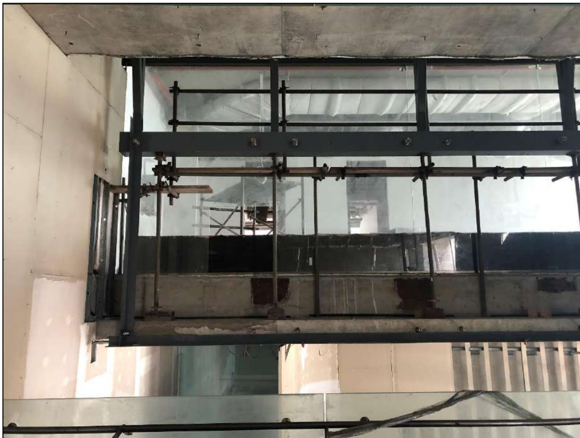
Figura 347: Ausência do vidro da divisória DV4b
