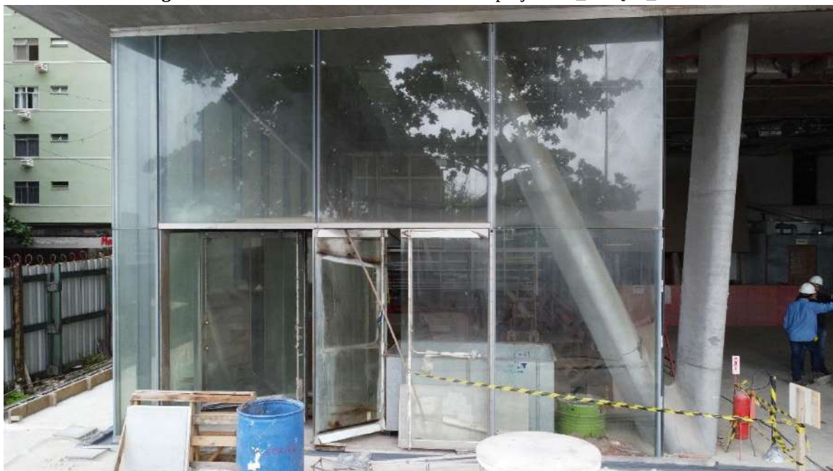
Figura 4: Porta EN1.2A executada conforme projeto PE_ARQSF_A323
