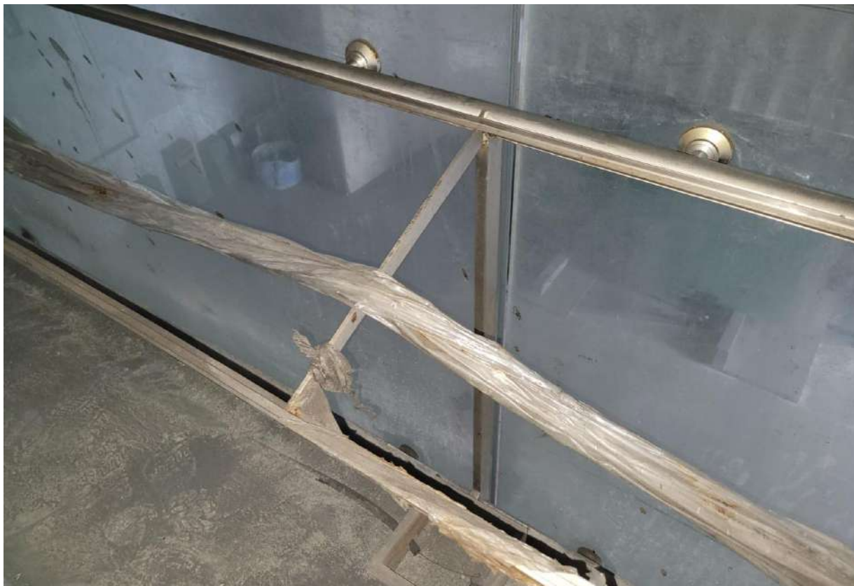
Figura 265: Demonstração da Patologia 1 nas Mesas Interativas do 3º pavimento
