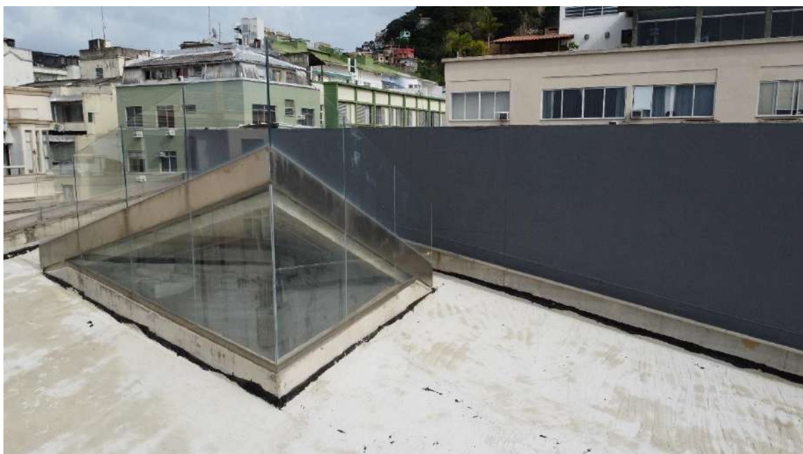
Figura 7: Vidro painéis WW20 e WW21 sem serigrafia
