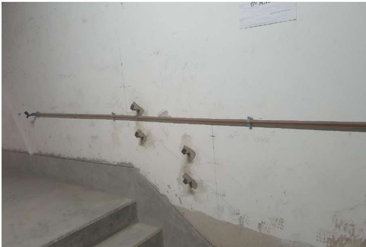
Figura 13: 1º Pavimento – Viga passando pelo local da JV3
