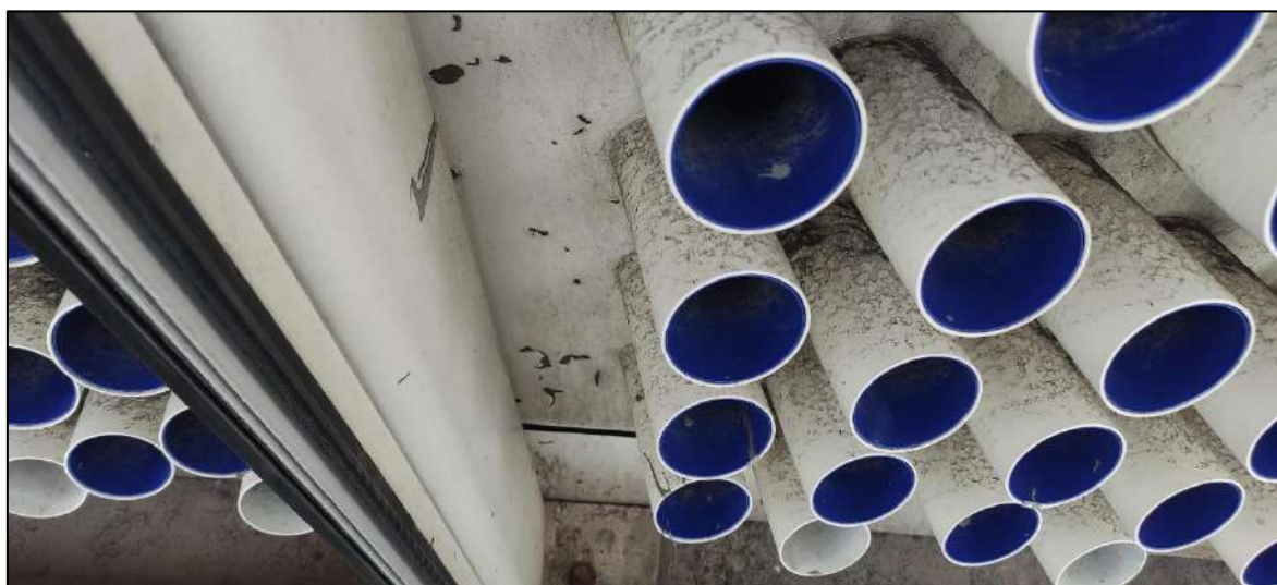
Figura 108: Demonstração da Patologia 9 no painel 4
