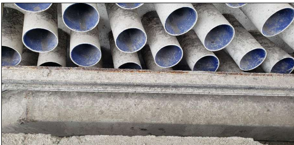
Figura 51: Demonstração da Patologia 11 no painel 3
