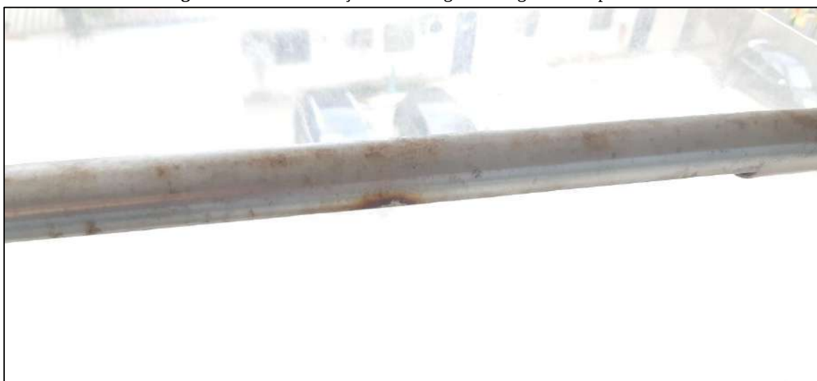
Figura 185: Demonstração da Patologia 17 no guarda-corpo G4A
