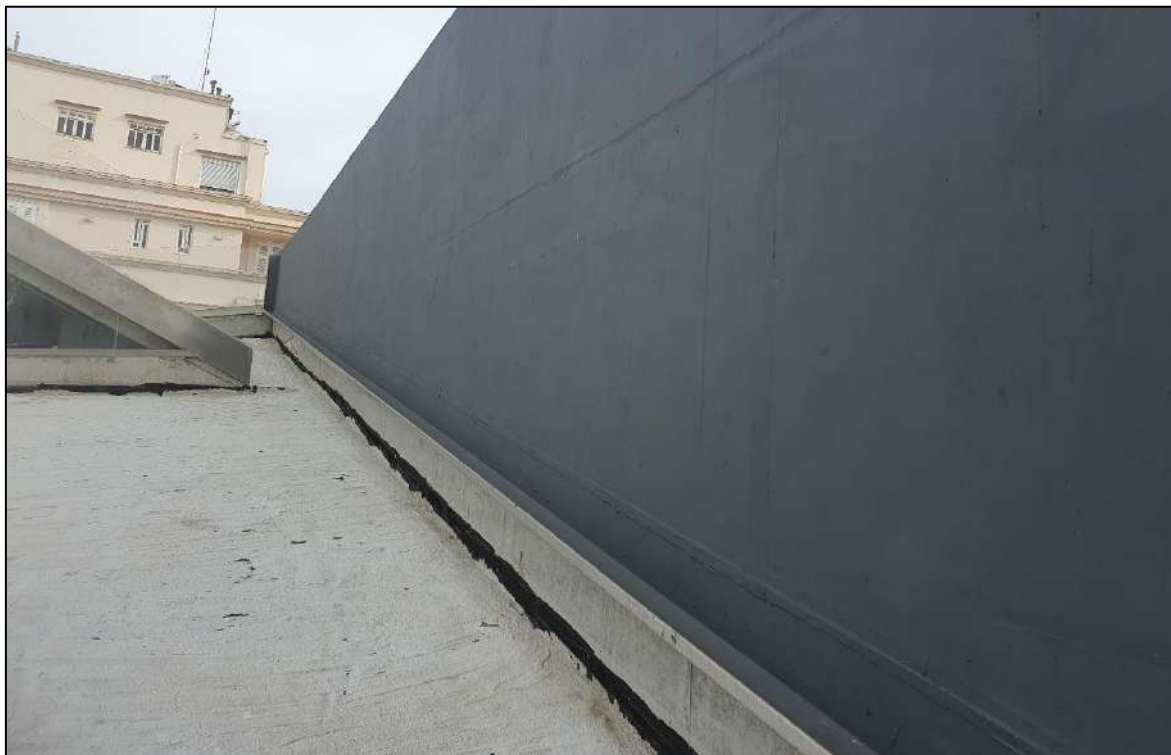
Figura 363: Ausência completa de todo o vidro e estrutura no revestimento EWS 1.3
