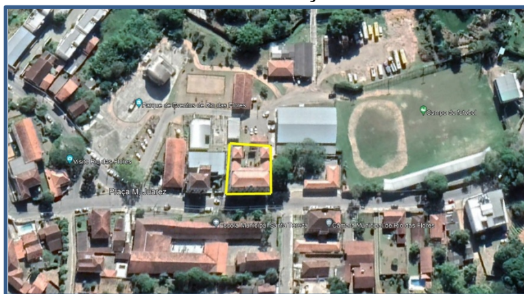
Figura 01 - Localização da Reforma.
