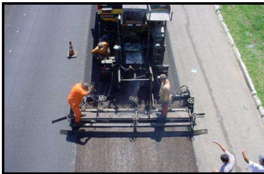
Ilustração de revestimento asfáltico
