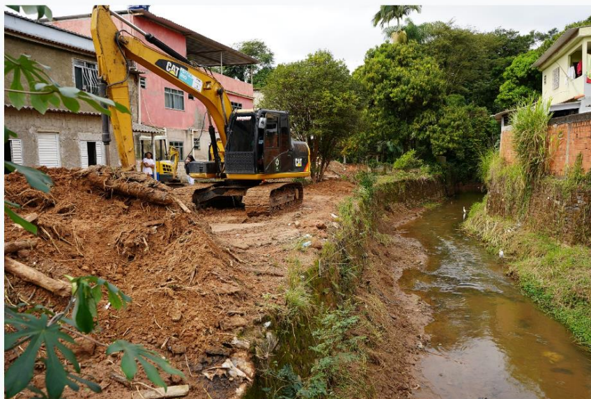
Trecho de cerca de 500 metros fica no bairro Santa Rita do Zarus; escavadeira deve trabalhar no local durante toda a semana
