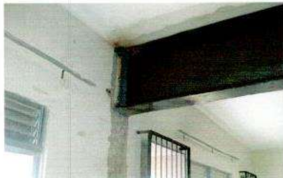
Execução de rebaixo em gesso envolvendo a viga metálica "I" de 20"
