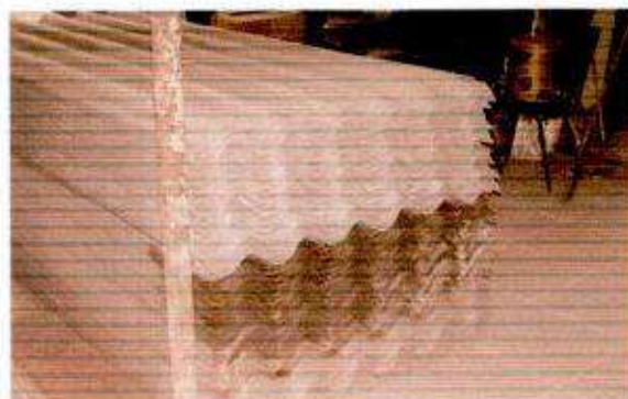
Execução da empena para execução de cobertura nove em telha 6mm ondulada
