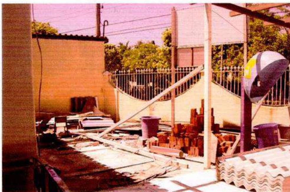
Remoção de coberturas frontal e outras demolições
