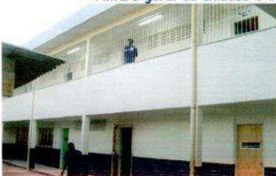
Pintura geral da unidade e instalação de grades de alumínio
