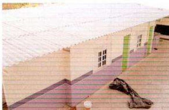
Execução de cobertura em estrutura metálica e policarbonato azul
