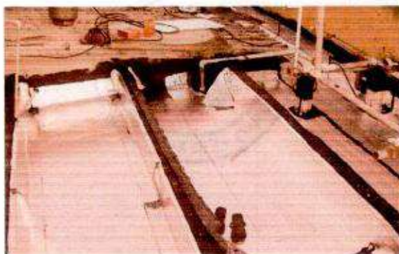
Execução de impermeabilização com manta aluminizada
