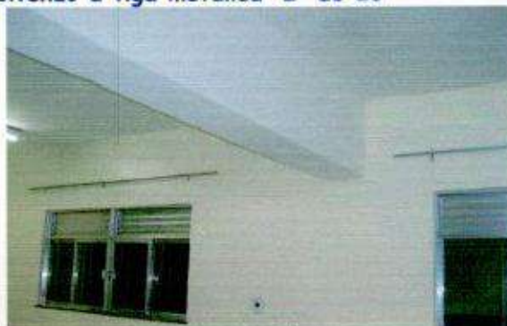
Execução de rebaixo em gesso envolvendo a viga metálica "I" de 20"
