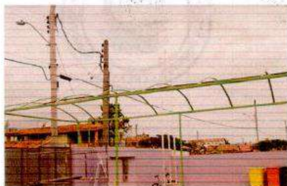
Execução de cobertura em estrutura metálica e policarbonato azul
