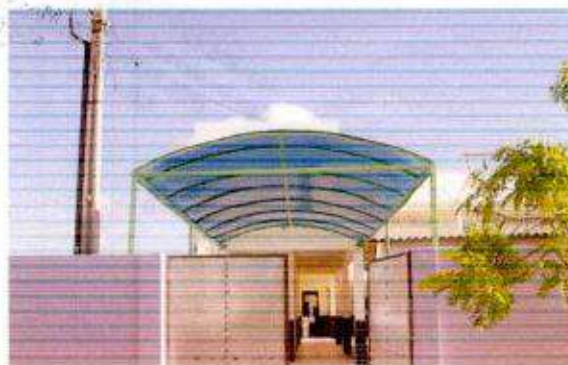
Execução de cobertura em estrutura metálica e policarbonato azul
