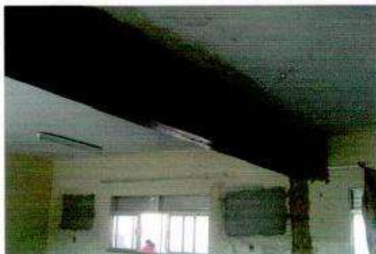
Execução de rebaixo em gesso envolvendo a viga metálica "I" de 20"
