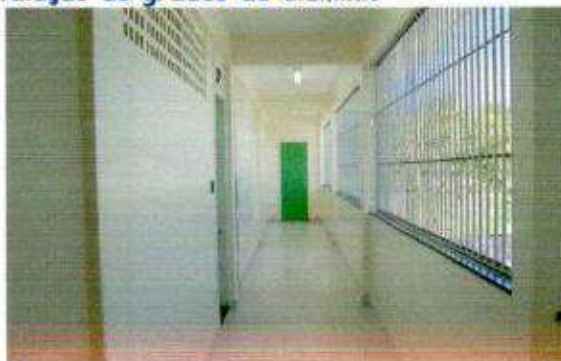
Pintura geral da unidade e instalação de grades de alumínio
