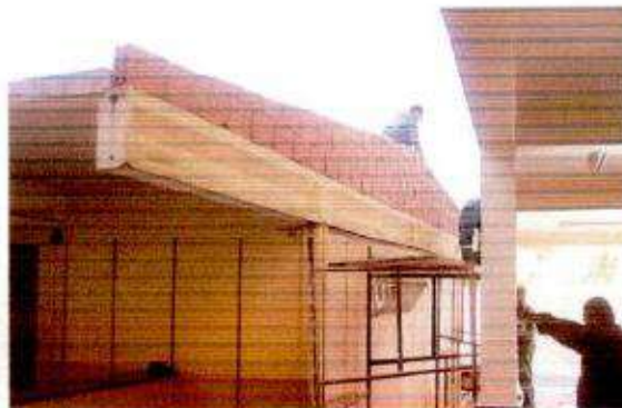
Execução de impermeabilização com manta aluminizada
