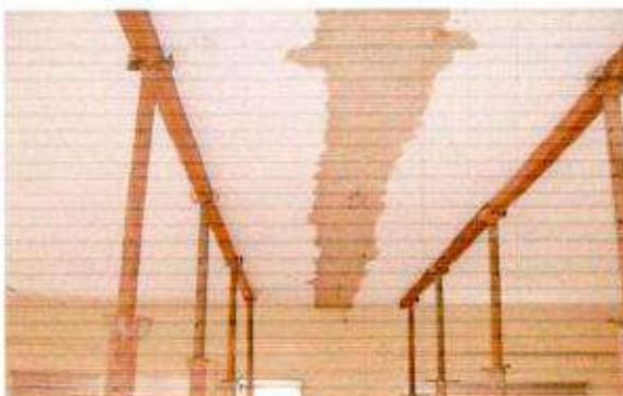
Execução da empena para execução de cobertura nove em telha 6mm ondulada
