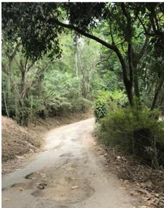
Figura 1 - Situação atual da principal via de acesso ao bairro de Boa Esperança, no município de Areal/RJ
