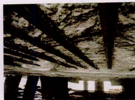
Figura 37: Área apicoada com acréscimo da armadura
