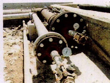
Figura 33: Realização teste de estanqueidade
