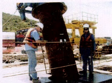
Figura 14: Instalação de sensores para execução de ensaio de carregamento dinâmico
