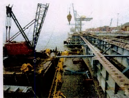
Figura 30: Remoção de estrutura metálica com Guindaste sobre flutuante
