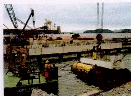
Figura 20: Transporte de Pré-moldados
