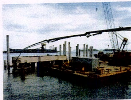
Figura 13: Concretagem de estaca através de bomba lança com alcance de até 46m
