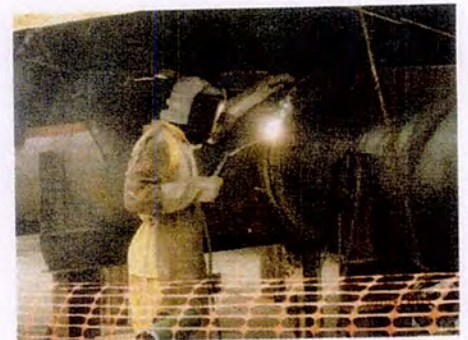
Figura 6: Solda em emenda de estaca metálica
