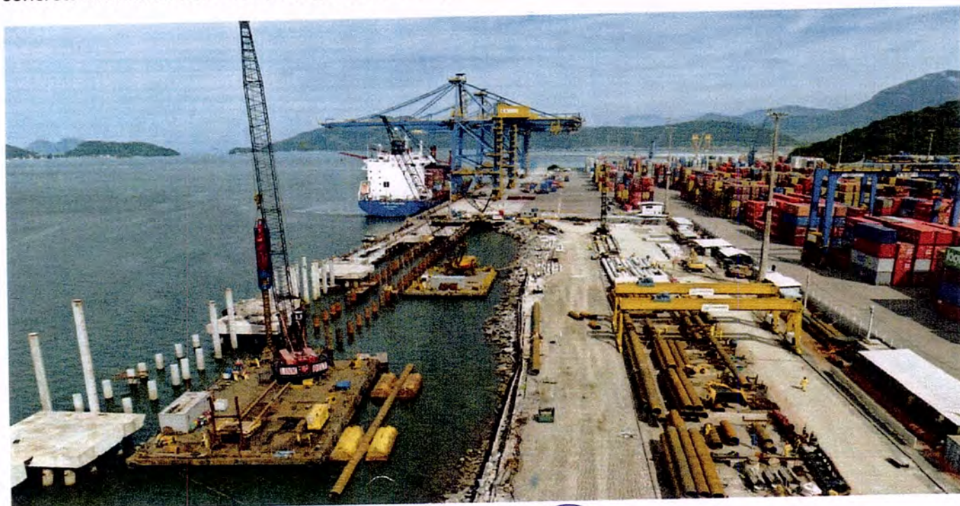
Figura 4: Cravação de estacas metálicas sobre flutuante
