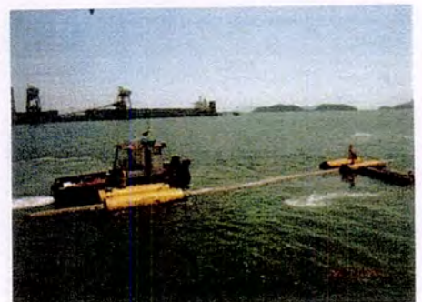
Figura 7: Transporte de estaca no mar
