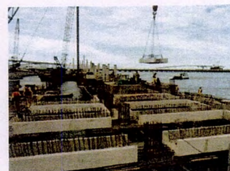
Figura 21: Montagem de vigas pré-moldadas
