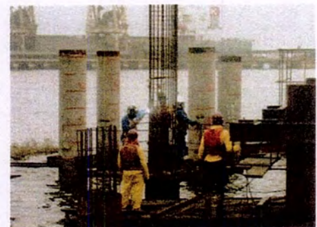
Figura 12: Posicionamento de armadura
