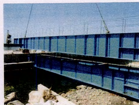
Figura 31: Beneficiamento das vigas metálicas da ponte de acesso
