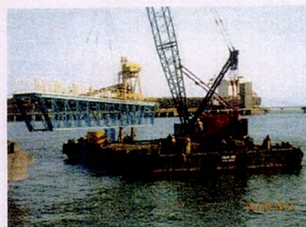
Figura 28: Remoção de Passarela Metálica
