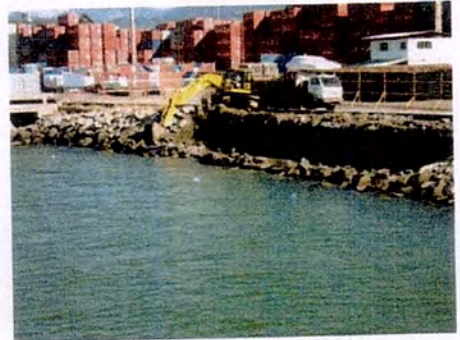
Figura 5: Rebaixamento de enrocamento para construção de embarcadouro provisório
