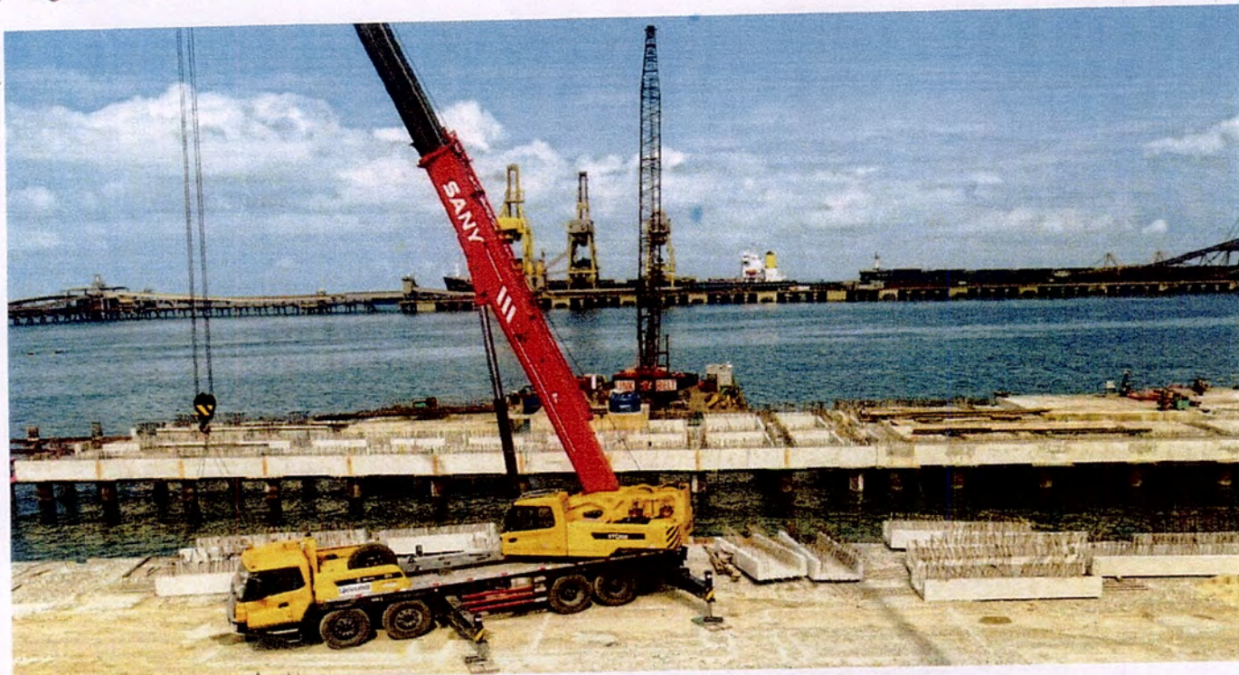
Figura 15: Vista do embarcadouro de pré-moldados e montagem sendo realizada com guindaste sobre flutuante
