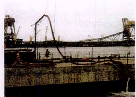
Figura 11: Limpeza interna da estaca pelo sistema Air Lift
