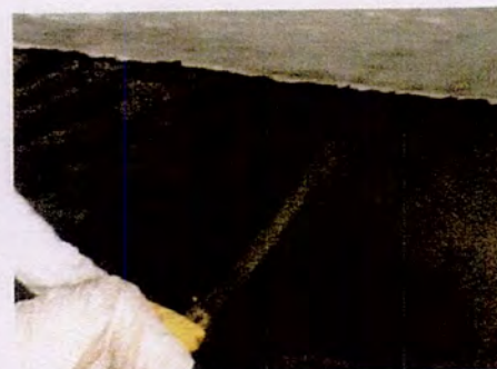
Figura 38: Aplicação de concreto projetado
