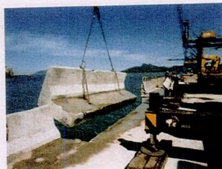
Figura 29: Demolição da superestrutura em concreto armado
