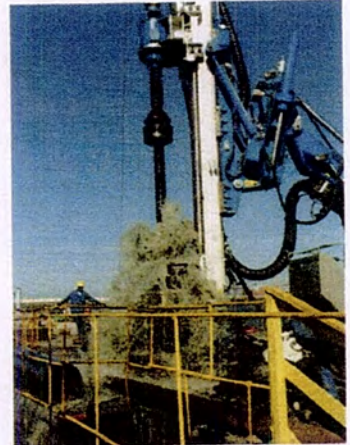
Figura 10: Perfuração de Enrocamento Ø 400mm
