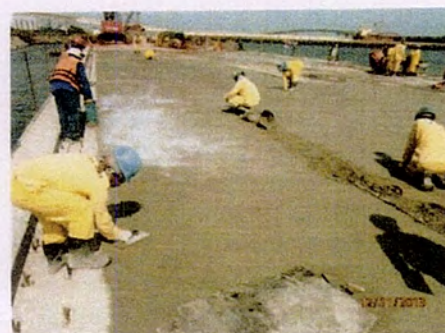
Figura 25: Concretagem "in loco" do piso e acabamento final da superestrutura
