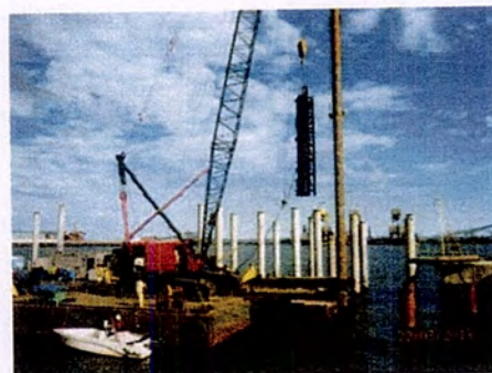
Figura 8: Verticalização de estaca e posicionamento do martelo de cravação
