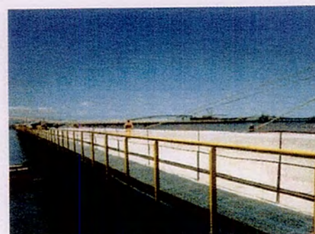
Figura 34: Passarela metálica ao longo do Cais
