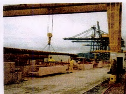
Figura 16: Movimentação de viga com pórtico 25t no pátio de pré-moldados
