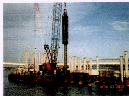
Figura 9: Cravação de Estaca sobre Flutuante
