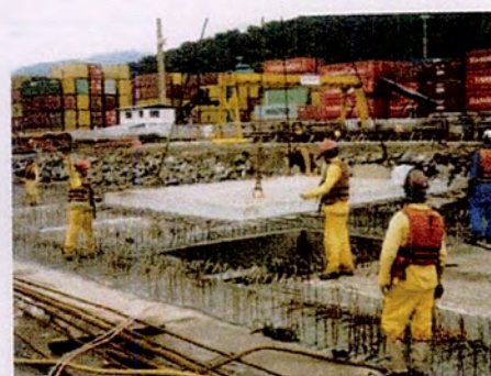
Figura 23: Montagem das lajes pré-moldadas
