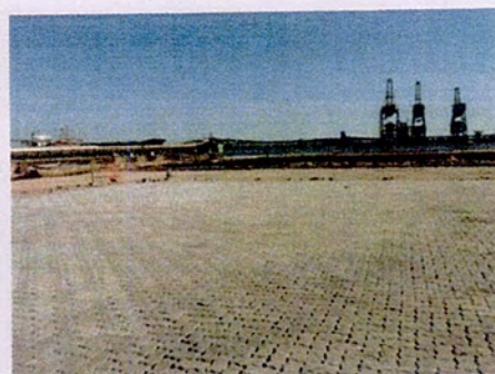
Figura 40: Recomposição de Pavimento Intertravado do pátio de containeres
