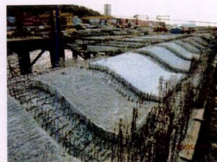
Figura 17: Pré-moldados especiais vigas e lajes irregulares
