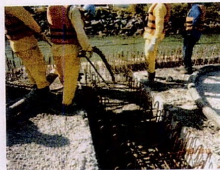
Figura 22: Concretagem de consolidação das vigas longitudinais e transversais
