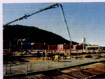
Figura 24: Concretagem "in loco" da sobrelaje
