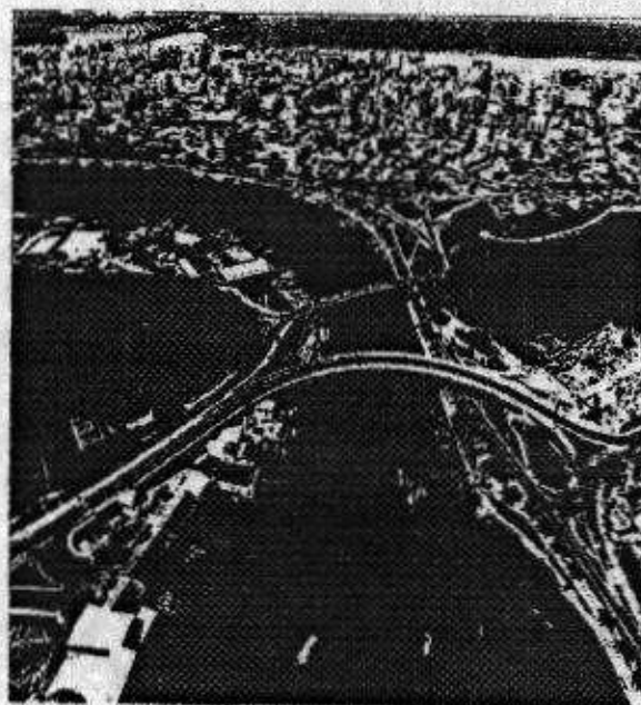
- Ponte sobre o Canal do Itajuru - Cabo Frio/RJ:
