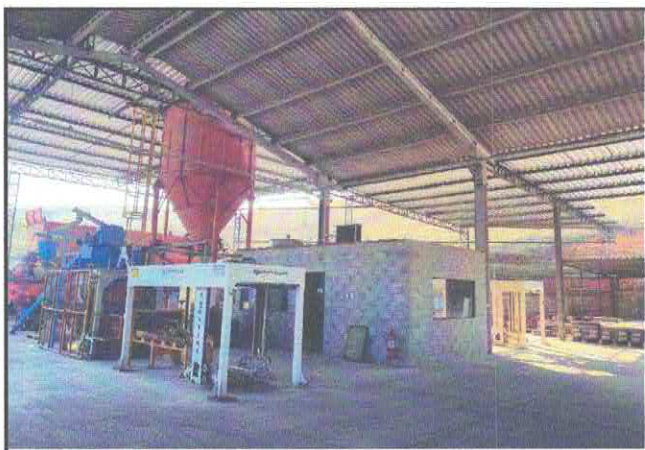
FÁBRICA ARTEFATOS DE CONCRETO
