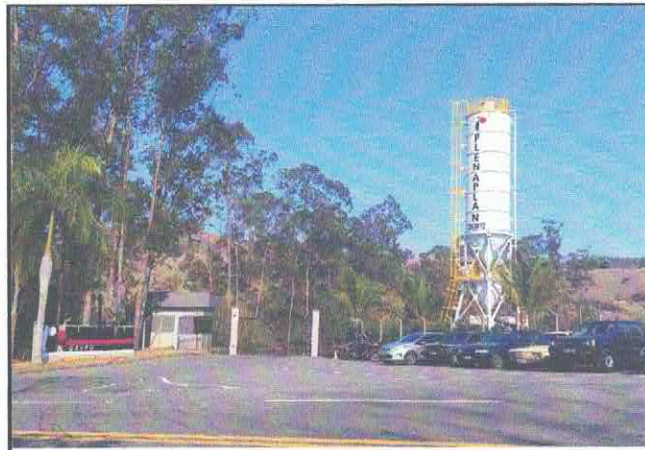
ENTRADA USINA PLENAPLAN
