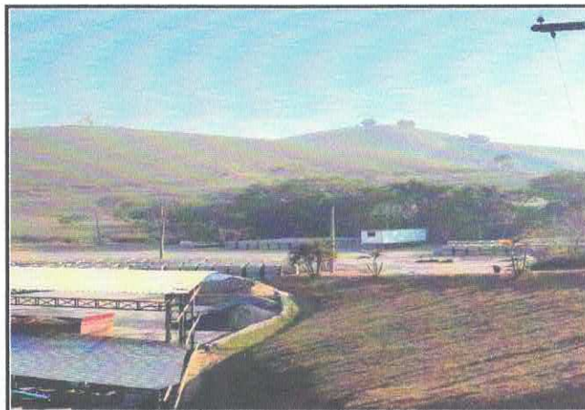
PÁTIO DE ARMAZENAMENTO DE ARTEFATOS DE CONCRETO
