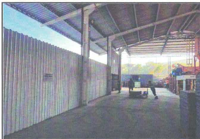
FÁBRICA DE ARTEFATOS DE CONCRETO
