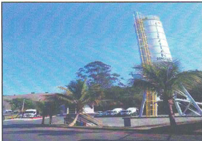
USINA DE CONCRETO E CAMINHÕES BETONEIRA
