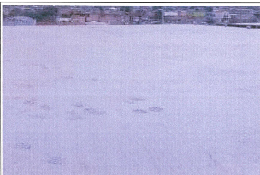
CONCRETAGEM DE LAJES PRÉ-MOLDADAS - BLOCO 1
