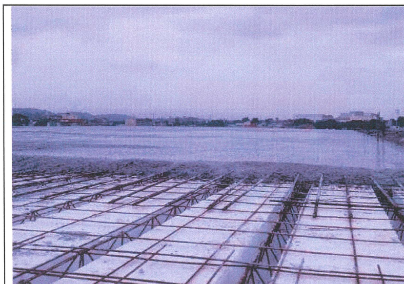
CONCRETAGEM DE LAJES PRÉ-MOLDADAS - BLOCO2
