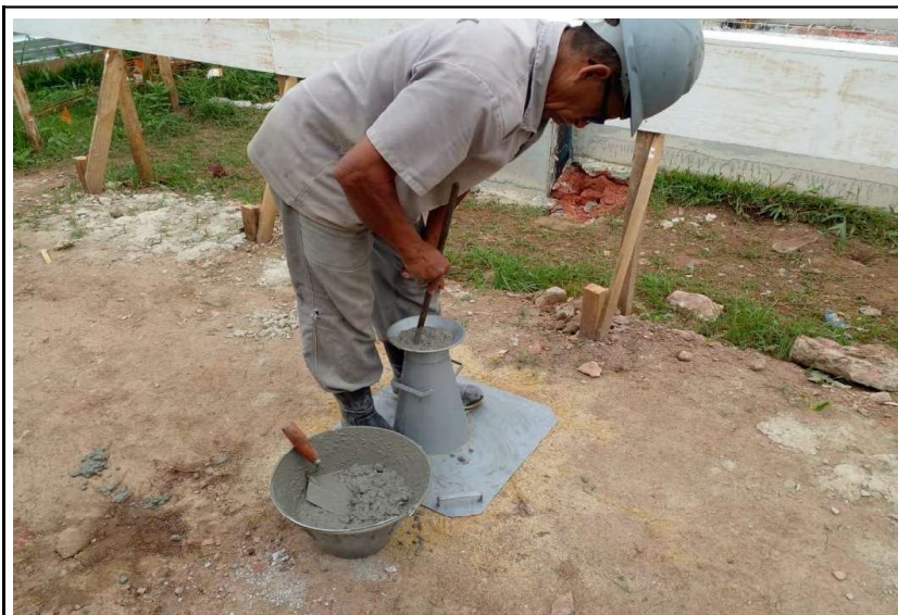
PREPARO DE TESTE DE ABATIMENTO PARA CONTROLE TECNOLÓGICO
