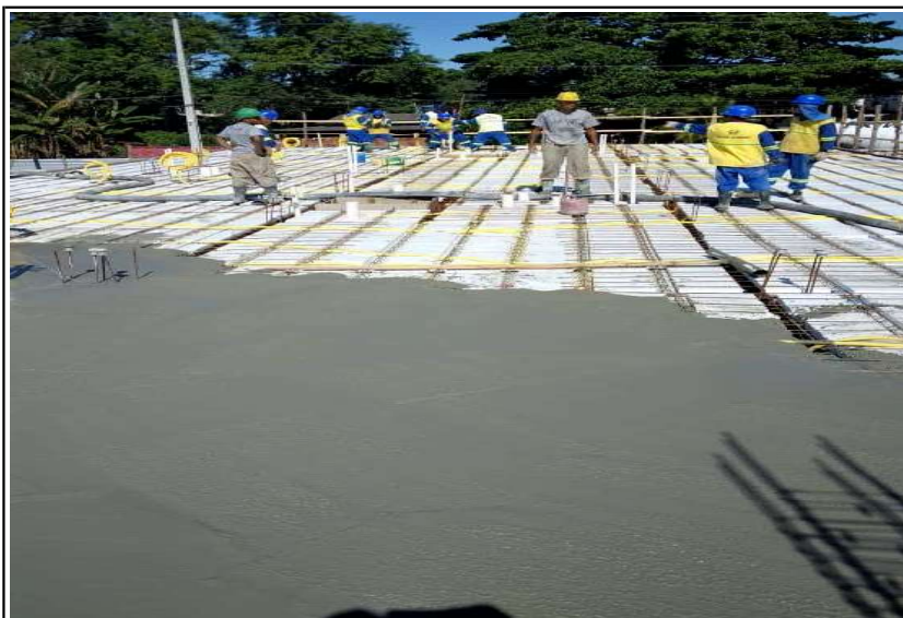
MONTAGEM DE INSTALAÇÕES E ARMADURAS NEGATIVAS DE LAJE PRÉ-MOLDADA 2º PAVIMENTO BLOCO 2
