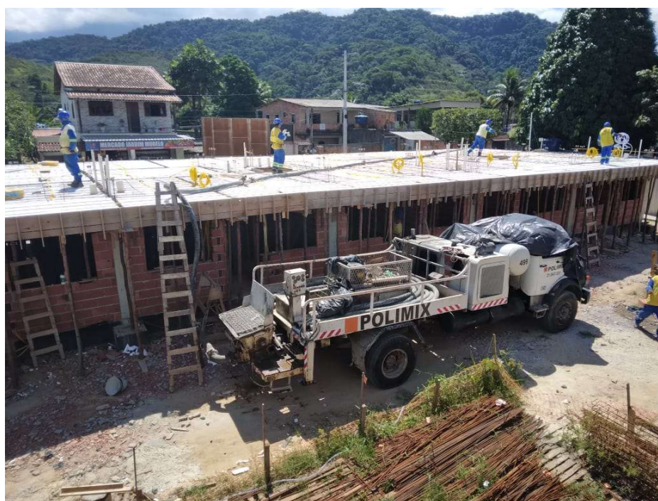
Foto 5 – Bombeamento do concreto para concretagem da laje.
