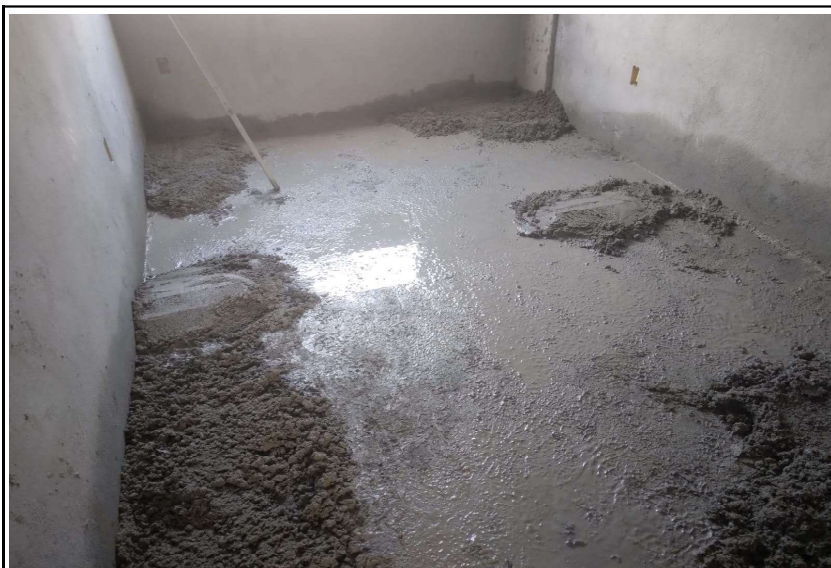
EXECUÇÃO DE CONTRAPISO APARTAMENTOS 1º PAVIMENTO BLOCO 1
