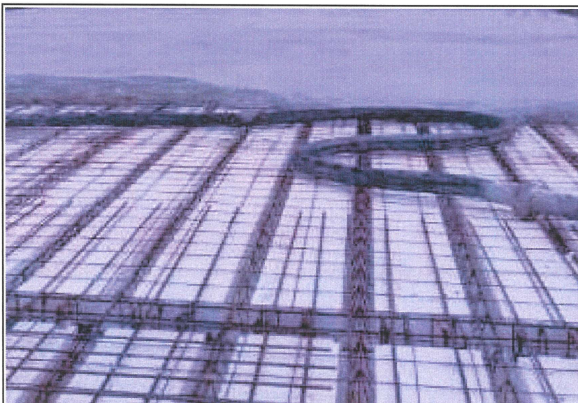
CONCRETAGEM DE LAJES PRÉ-MOLDADAS - BLOCO2
