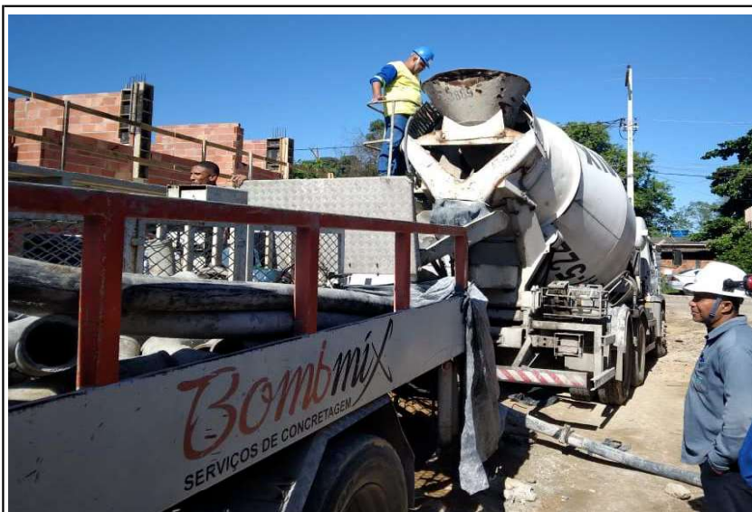
INSPEÇÃO PARA RECEBIMENTO DO CAMINHÃO DE CONCRETO
