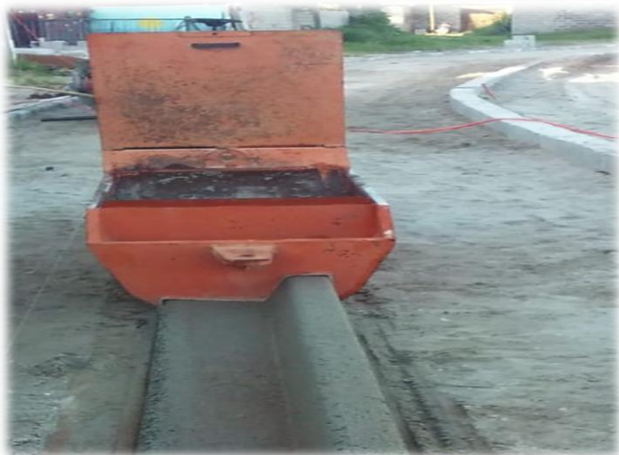
EXTRUSORA DE SARJETA E MEIO - FIO CONJUGADO
