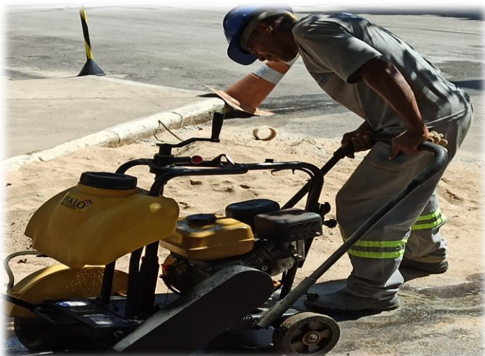
CORTADORA DE CONCRETO E ASFALTO
