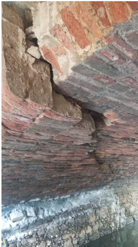
Ponte na rua Mr. Watkins, sobre o rio da Dona Eugenia
