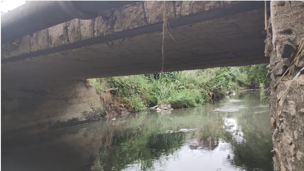
Ponte na Av. Delfina Borges sobre o rio da Prata
