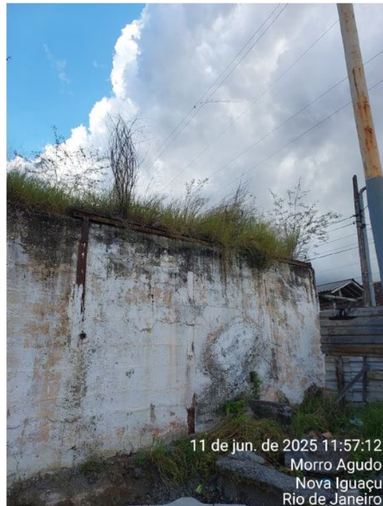
Imagem 06: Trecho de muro de contenção a demolir da Rua Lafaiete Pimenta, Comendador Soares, Nova Iguaçu/ RJ.
