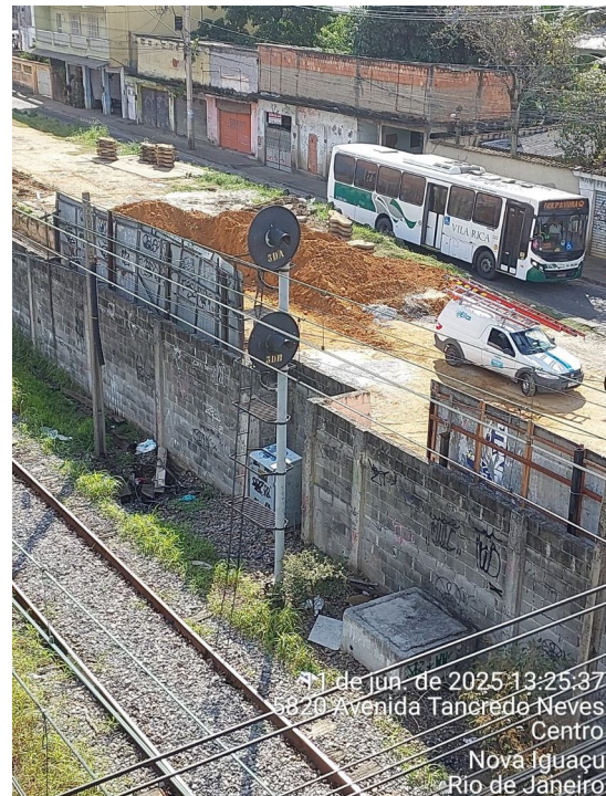
Imagem 12: Sinaleiro existente a remanejar dentro do muro da Av. Tancredo Neves, Comendador Soares, Nova Iguaçu/ RJ.
