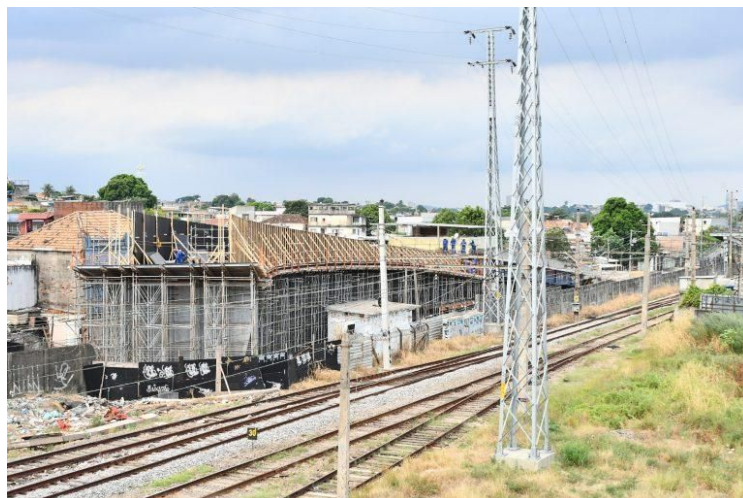
Imagem 02, 03 e 04: Obra de implantação do Viaduto
