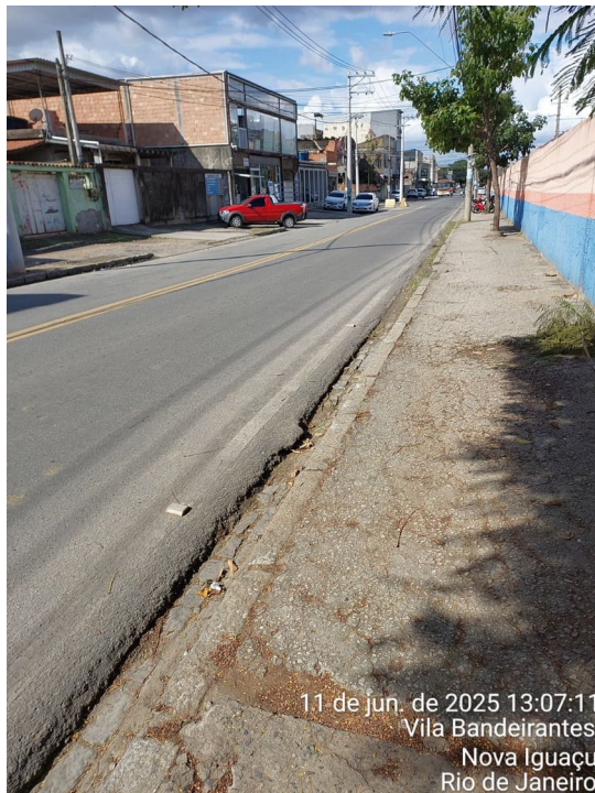
Imagem 11: Trechos da Av. Tancredo Neves de área a recapear e reconstrução de calçada, Comendador Soares, Nova Iguaçu/ RJ.
