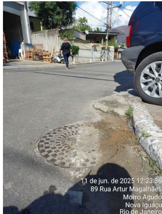
Imagem 08: Poço de visita existente na Rua Arthur Magalhães para o deságue de um dos trechos de drenagem.
