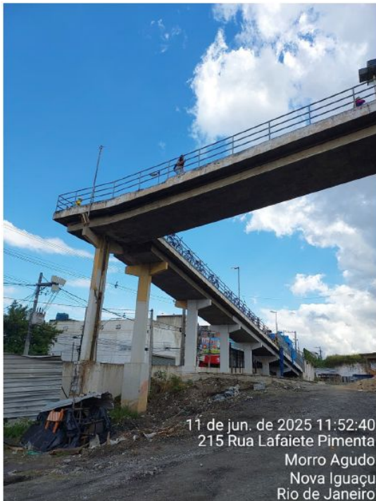
Imagem 05: Trecho de passarela a demolir da Rua Lafaiete Pimenta, Comendador Soares, Nova Iguaçu/ RJ.
