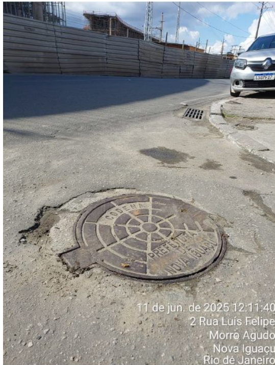
Imagem 07: Poço de visita existente na Rua Luiz Felipe para o deságue de um dos trechos de drenagem.
