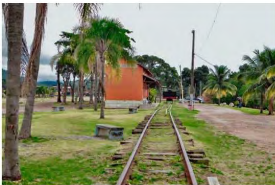
Foto 1 - Localização da reforma
