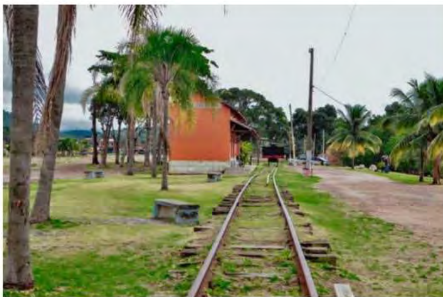
Foto 1 - Localização da reforma
