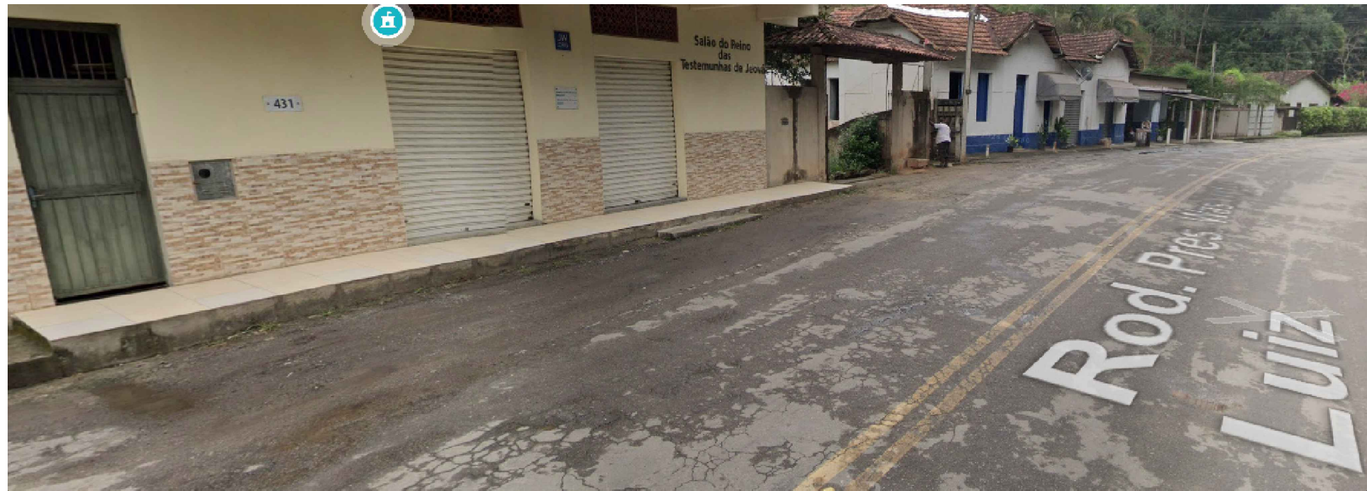
Figura 4 - Calçada de concreto revestida com piso ceramico existente.
