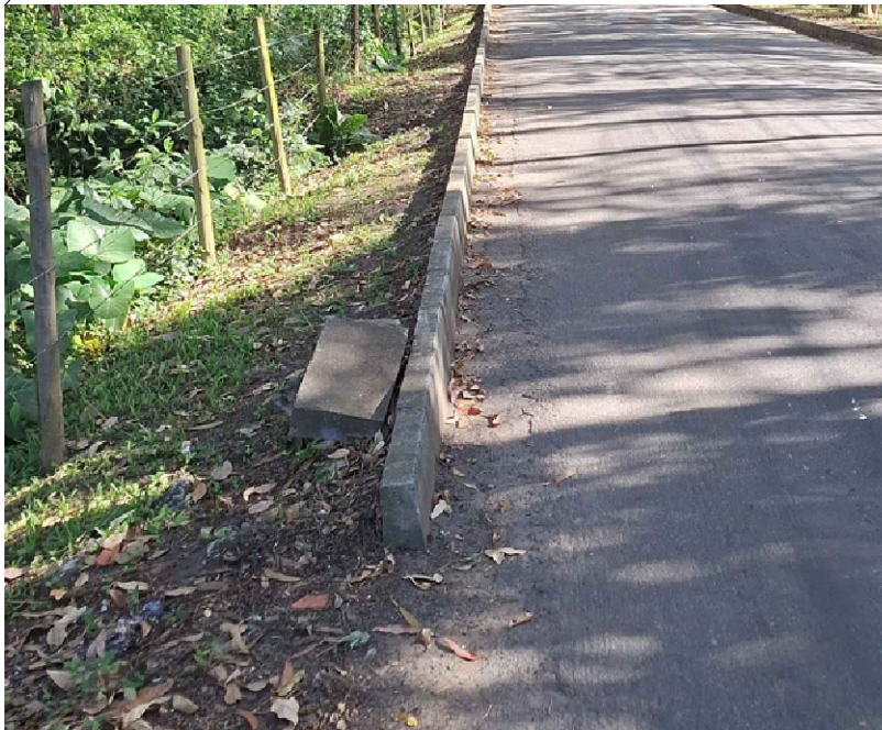
Figura 3 - Meio fio tipo tento existente.
