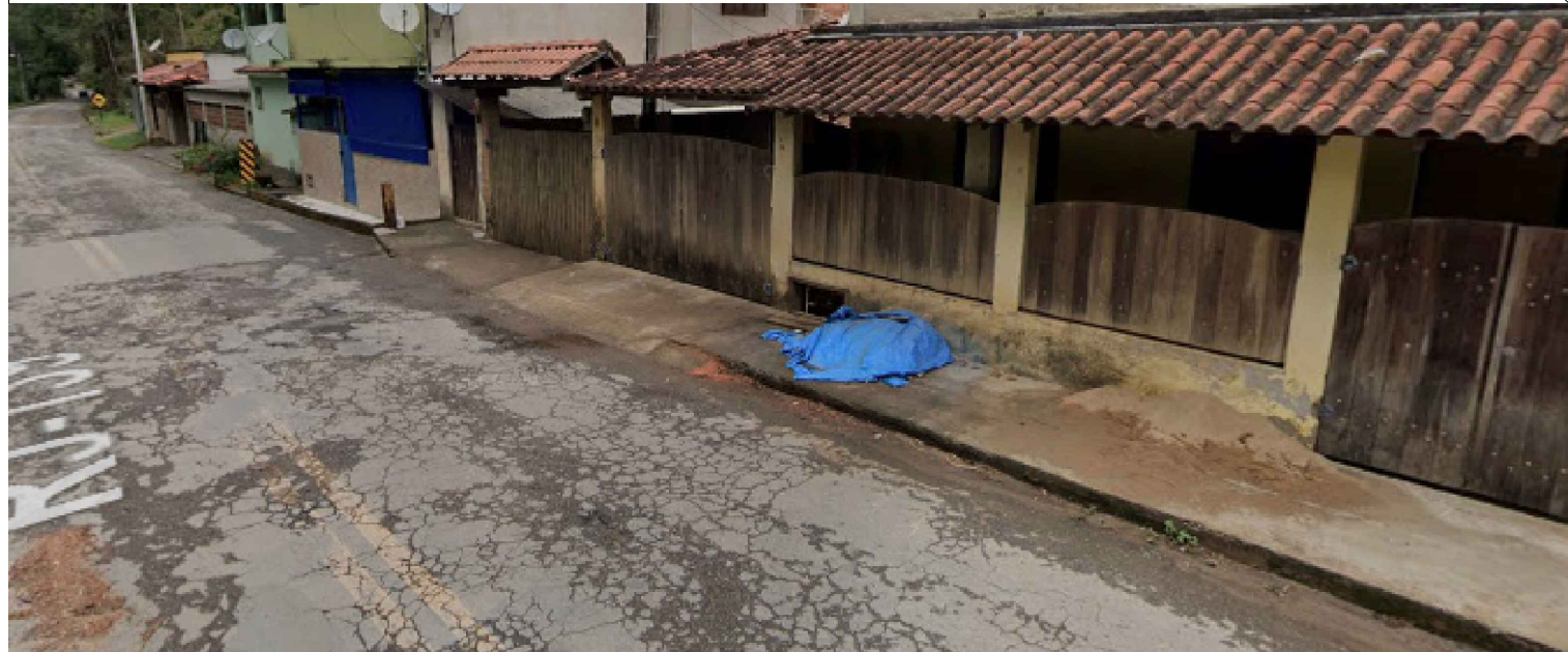
Figura 2 - Calçada de concreto existente com acesso às garagens.
