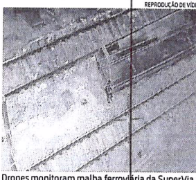
Drones monitoram malha ferroviária da SuperVia
