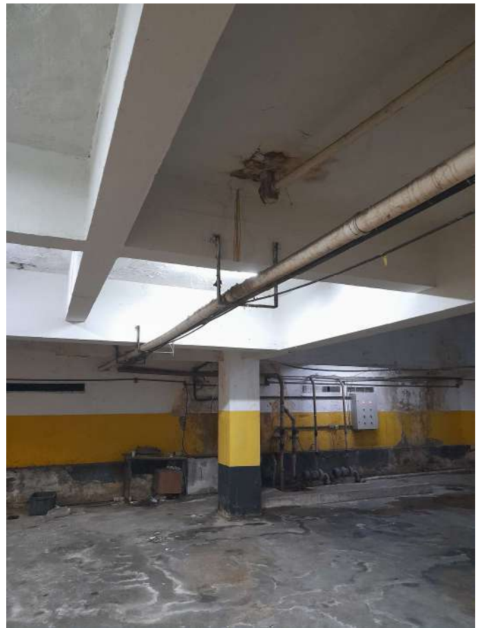
Vagas comprometidas pelas infiltrações.
