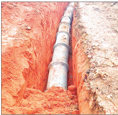
Obras de infraestrutura
