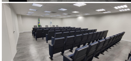
Modernização de gabinetes, ambientes de trabalho e construção de auditório
