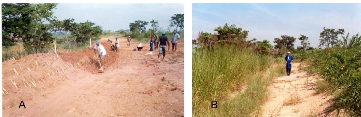
Figura 6: Plantio do capim Vetiver (A) e seis meses após o plantio (B) no Morro do Radar - Aeroporto Internacional do Rio de Janeiro – Galeão/Antônio Carlos Jobim.
