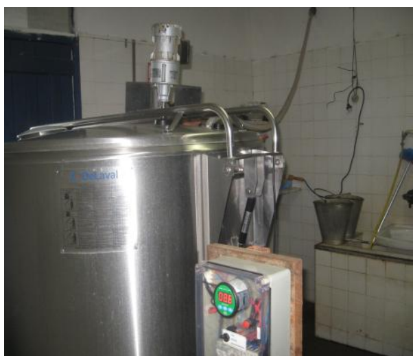
Figura 24: Controle de temperatura do tanque de resfriamento na entrada do leite.
