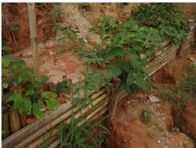
Figura 9: Paliçada retendo sedimentos após a reforma, em 06/05/2012.
