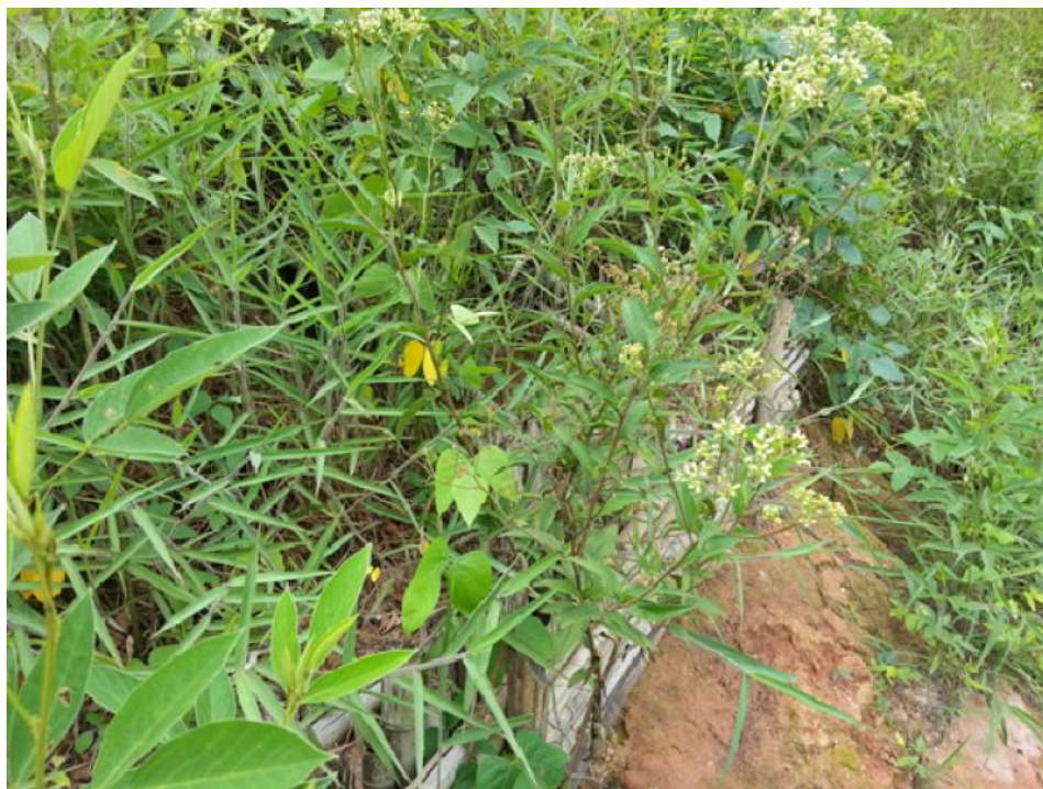
Figura 10: Paliçada retendo sedimentos e com cobertura vegetal desenvolvida, em 23/01/2013.
