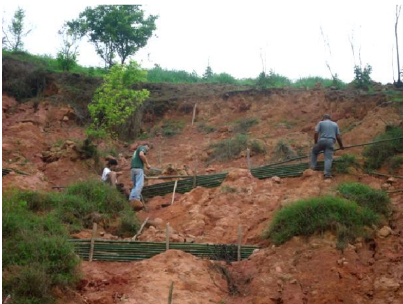
Figura 2: Paliçadas de bambu introduzidas na subárea 2, em 27/11/2011.
