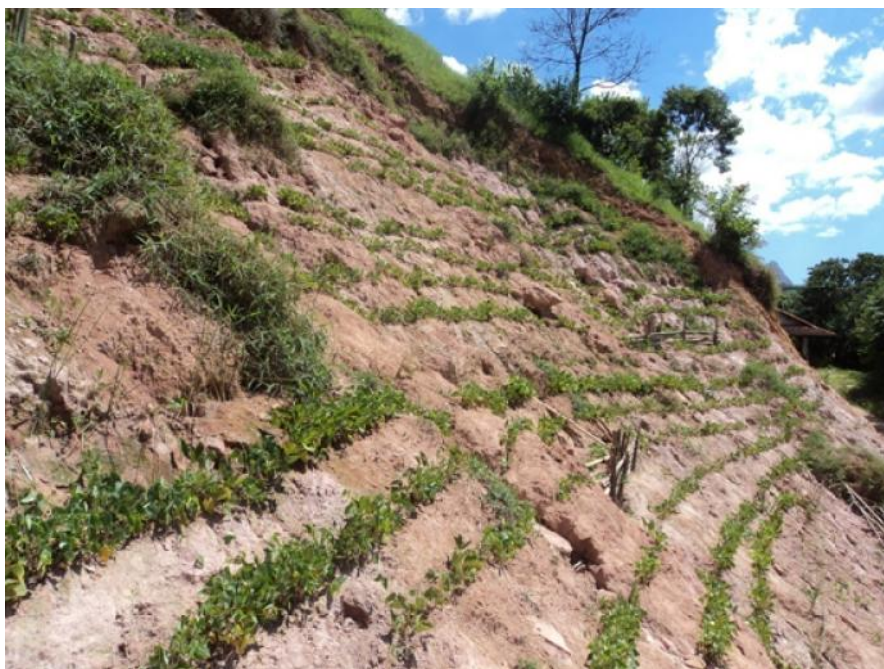
Figura 4: Leguminosas de crescimento rápido vegetando a encosta, em 01/10/2013. (Foto: Tiago de Andrade Chaves)
