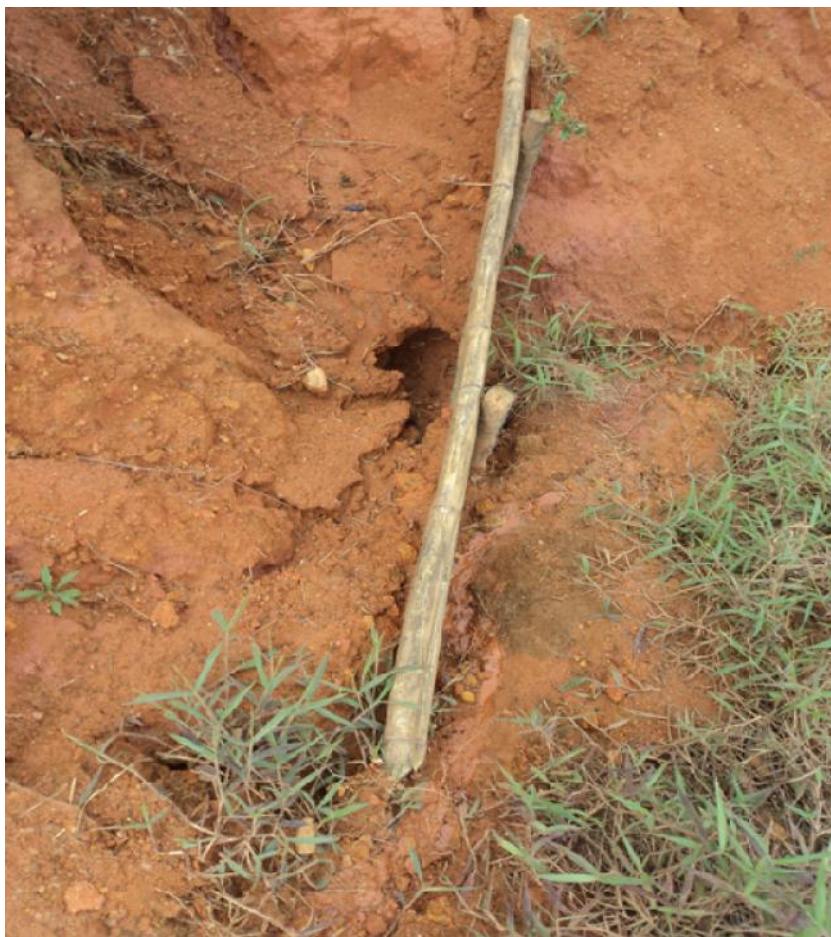
Figura 8: Paliçada com problemas para reter os sedimentos, em 28/02/2012.
