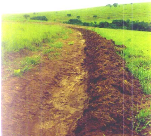
Figura 20 - Detalhe de terraço com gradiente construído com arado de disco - Prados-MG (out/95).
