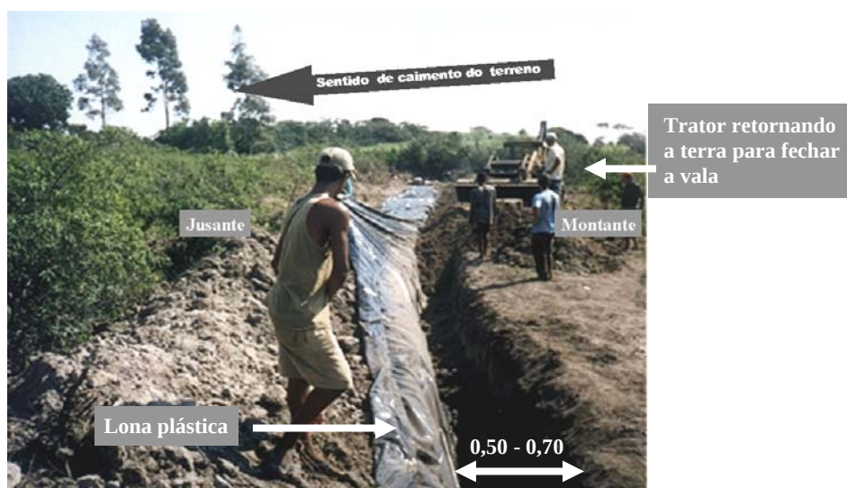
Figura 3: Fechamento da vala.
