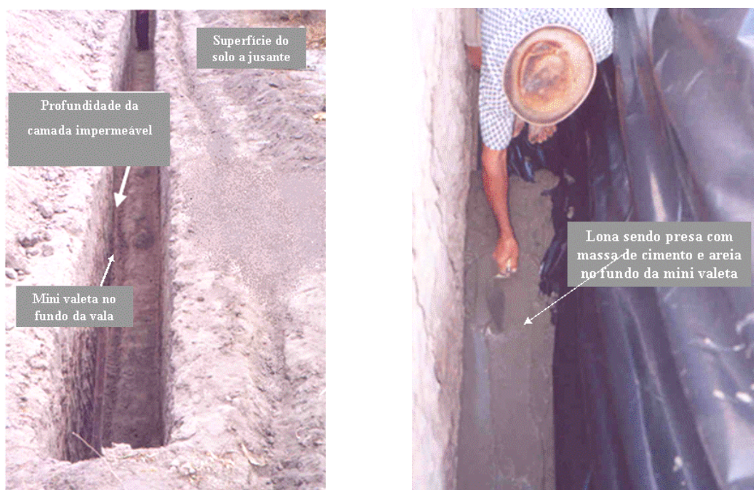
Figuras 1 e 2: Detalhes da instalação da lona.
