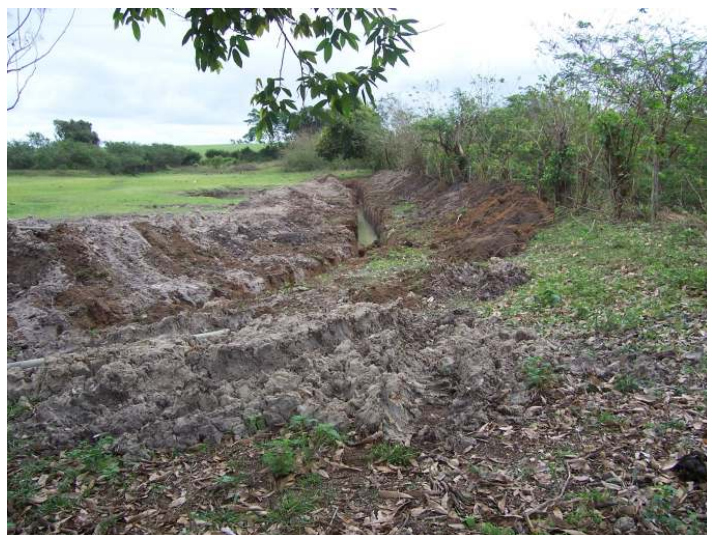
Figura 3: Abertura da trincheira para posterior colocação da lona plástica. Microbacia Brejo da Piedade – Quissamã, agosto de 2009.
