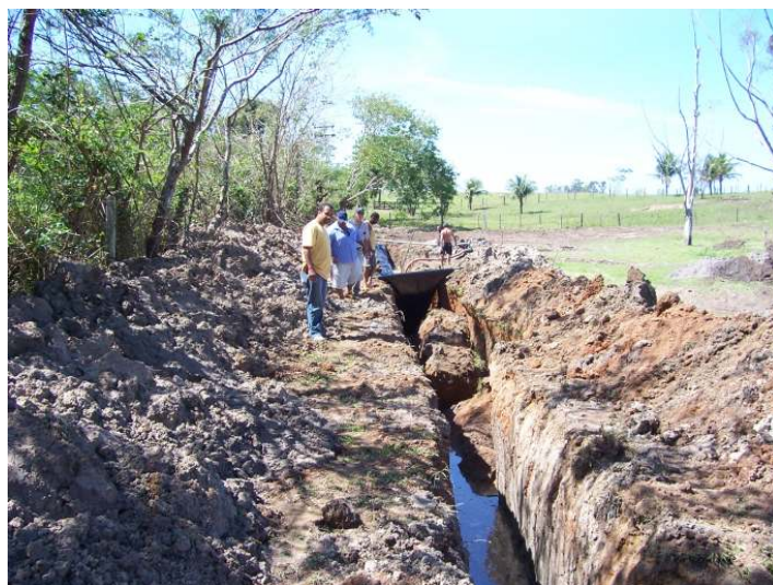
Figura 4: Colocação da lona plástica na trincheira. Microbacia Brejo da Piedade – Quissamã, agosto de 2009.
