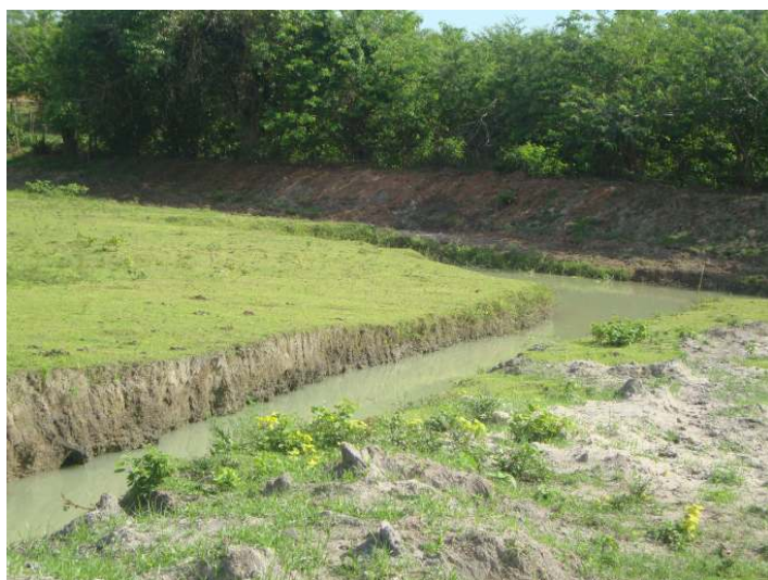
Figura 5: Vista do local onde foi implantada a barragem. Microbacia Brejo da Piedade – Quissamã, dezembro de 2010.
