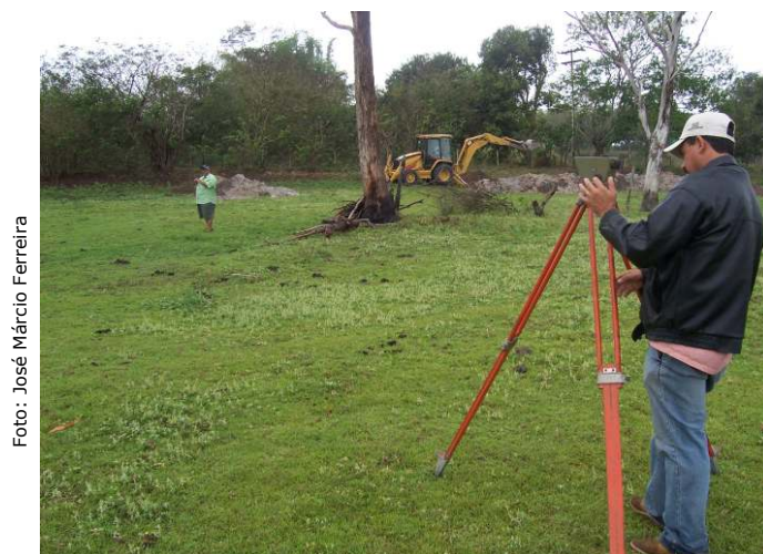
Figura 2: Levantamento topográfico no local de implantação da barragem. Microbacia Brejo da Piedade – Quissamã, agosto de 2009.
