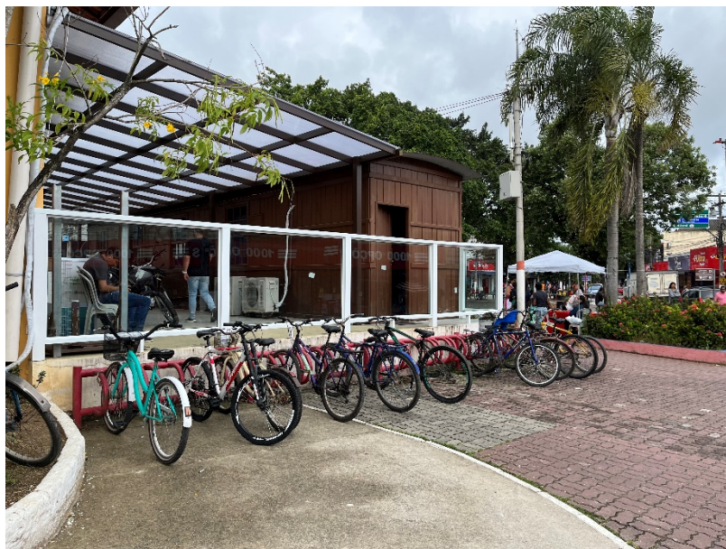
Figura 156: Paraciclo instalado ao lado do centro de informações turísticas em Maricá
