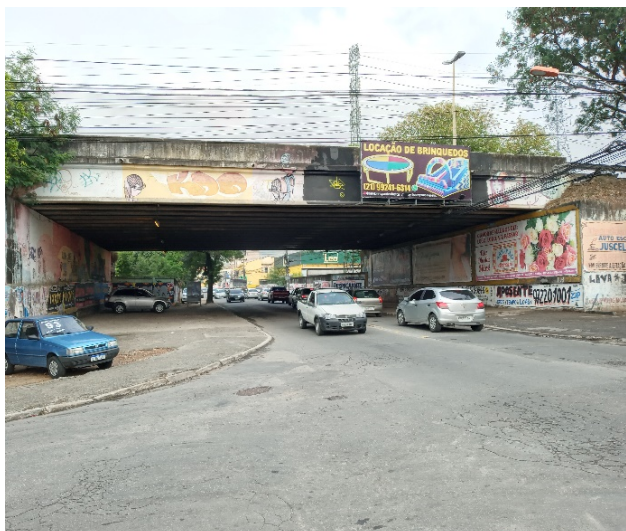
Figura 145: Mergulhão sob a Via Light na Av. Carlos Marques Rollo
