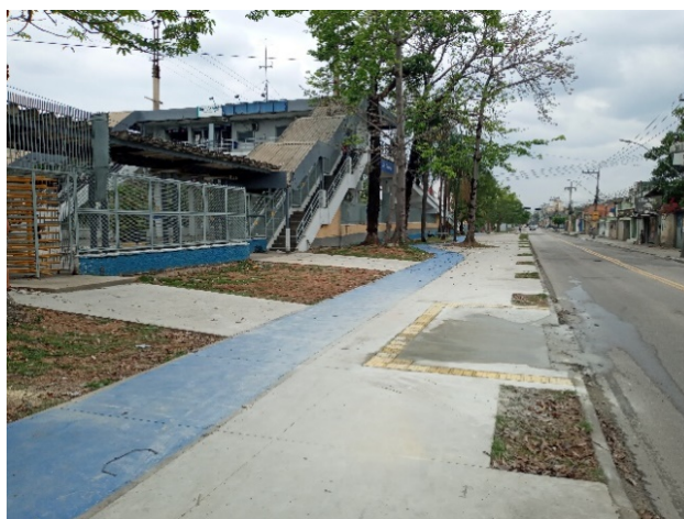
Figura 136: Acesso à Estação Juscelino na Av. Feliciano Sodré
