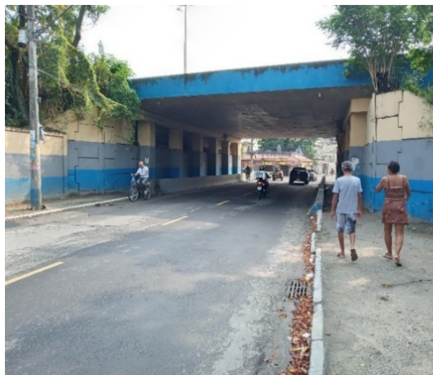
Figura 146: Mergulhão sob a Via Light na R. Marcial
