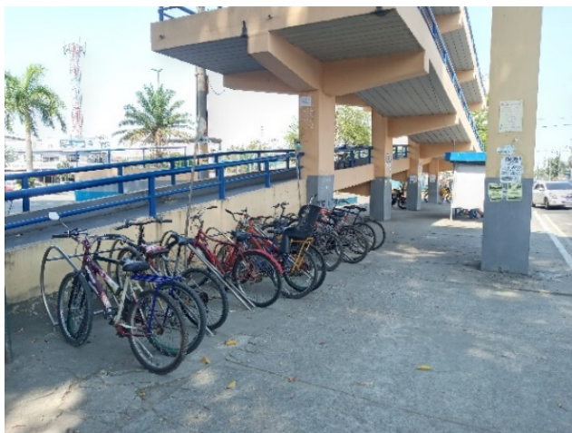
Figura 141: Paraciclos junto à passarela de acesso à Estação Mesquita, na Praça João Luis Nascimento
