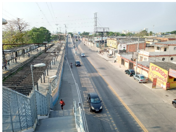
Figura 135: Acesso à Estação Edson Passos na Av. Pres. Costa e Silva
