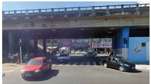
Figura 133: Travessia da RJ-104 pela R. Dr. Alfredo Backer
