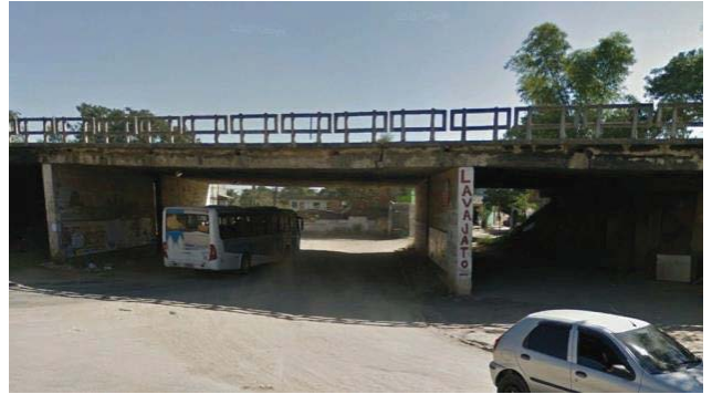
Figura 129: Travessia da RJ-104 pela Av. Itamarati
