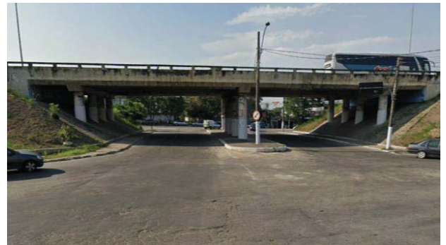
Figura 131: Travessia da RJ-104 pela Av. Itamarati
