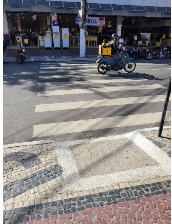
Figura 121: Rampa para travessia de PcD
