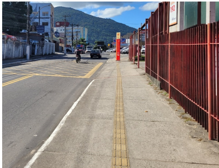
Figura 122: Calçada com piso tátil direcional
