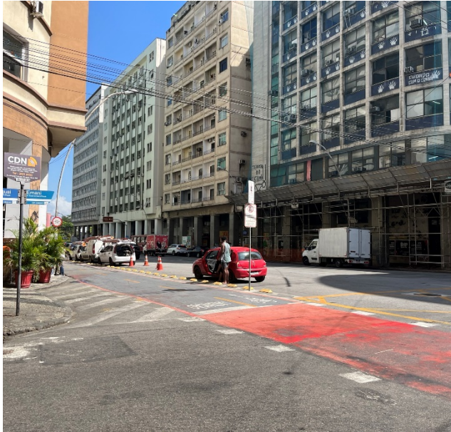
Figura 161: Ciclofaixa com estacionamento ao lado no centro de Niterói
