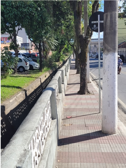
Figura 118: Calçada com largura insuficiente
