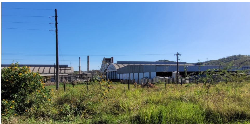
Figura 106: Fábrica da AMBEV em Cachoeiras de Macacu
