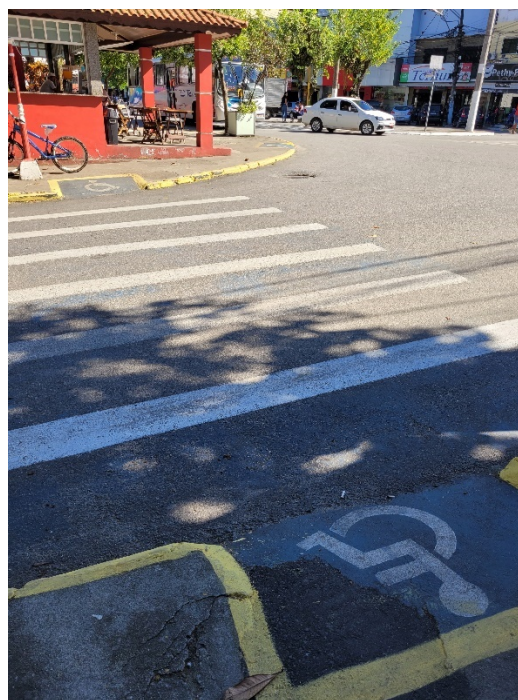
Figura 12: Rampa para PcD
