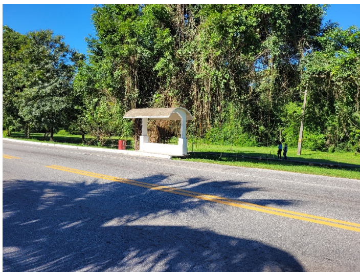
Figura 131: Ponto de ônibus na rodovia
