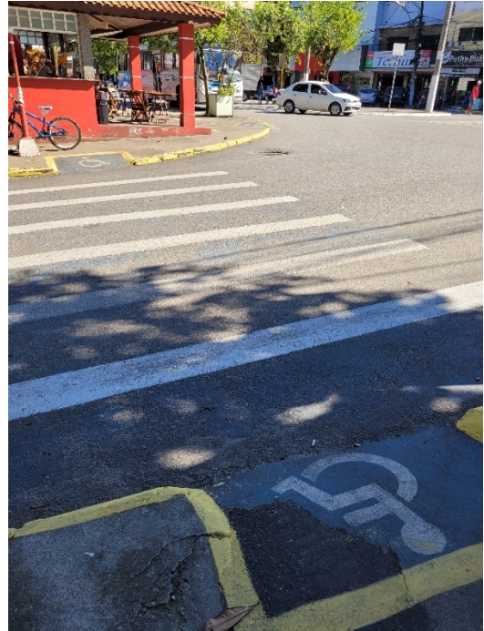
Figura 148: Rampa para PcD
