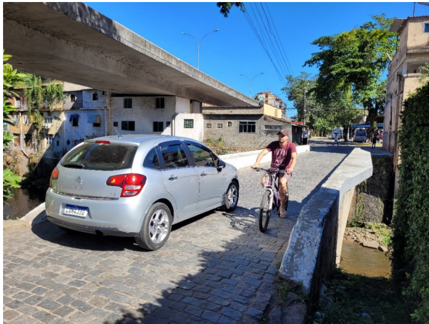
Figura 118: Pontes sobre o Rio Macacu (Ponte da RJ-116 acima à esquerda e ponte para travessia local em primeiro plano)
