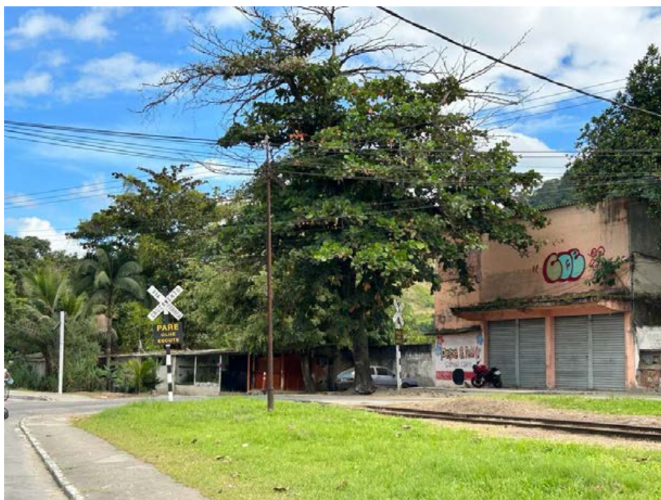
Figura 103: Ponto 2 - Interseção viária entre linha férrea e Est. do Bananal, próximo a parada Bananal Fonte: Elaborado pelo Consórcio
