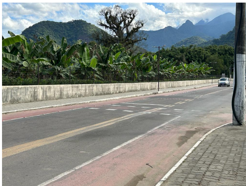
Figura 121: Ciclofaixa na Rua Marta Alcantara Fares, com sinalização horizontal na travessia e iluminação específica
