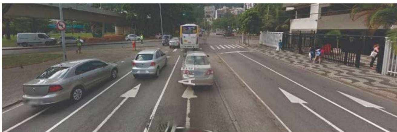
TRECHO DE INTERVENÇÃO - ATUALIDADE
