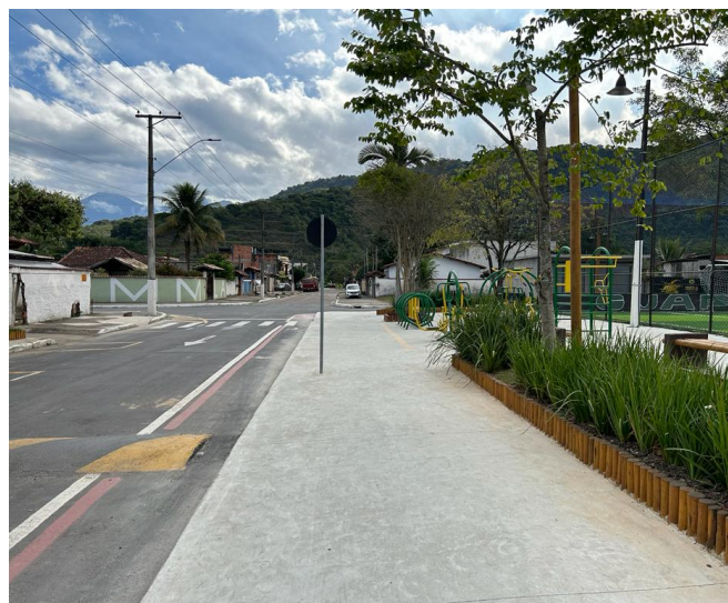
Figura 126: Revitalização do passeio público na praça Aguinaldo Pereira
