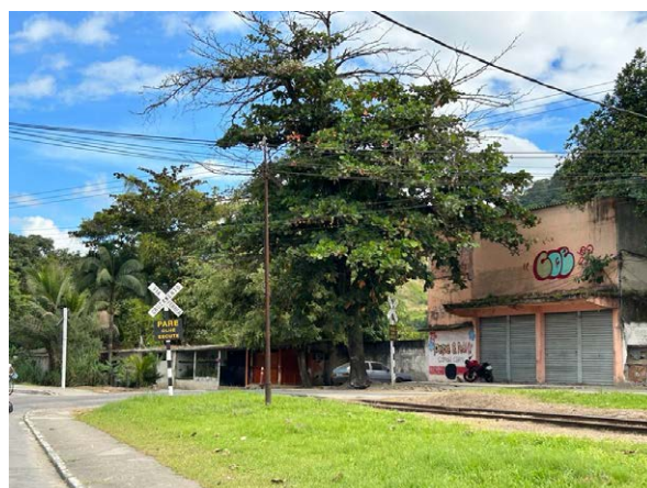
Figura 168: Ponto 2 - Interseção viária entre linha férrea e Est. do Bananal, próximo a parada Bananal
