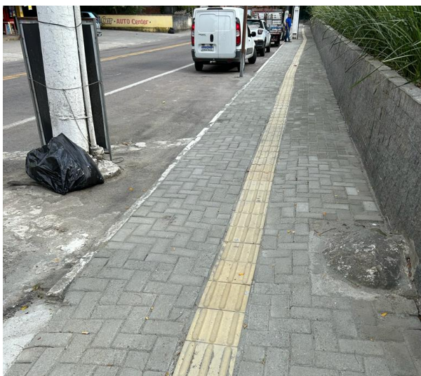
Figura 125: Revitalização com piso podotátil na Av. Dedo de Deus
