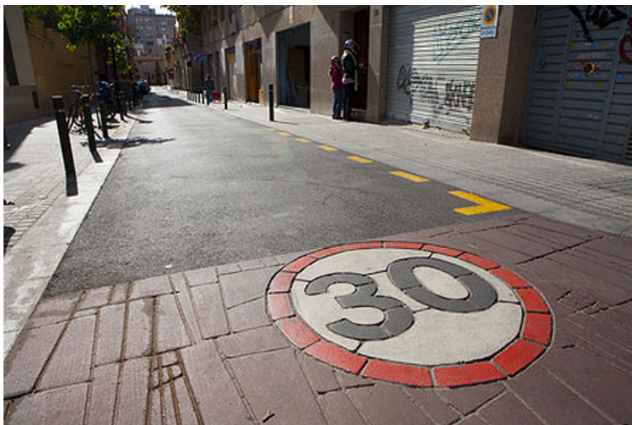
Figura 214: Demonstração de Sinalização, Rua e Calçadas Diferenciadas em Zona 30
