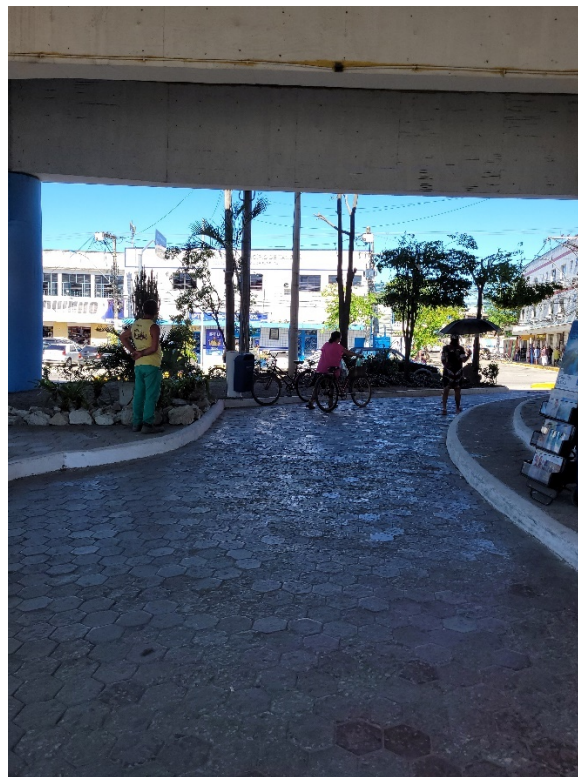
Figura 131: Passagem para pedestres sob o viaduto da BR-101
