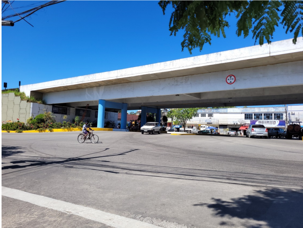
Figura 106: Vista lateral da passagem inferior na BR-101
