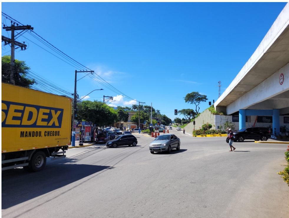
Figura 107: Conflitos na passagem inferior na BR-101 na Rua Antônio Teixeira de Macedo
