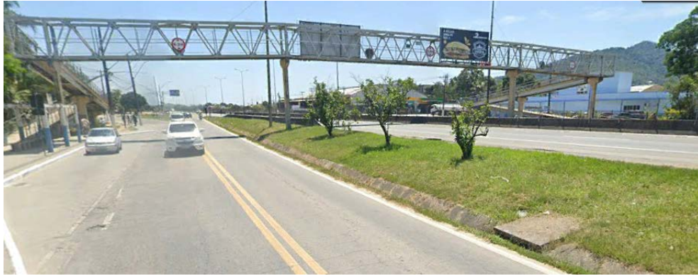
Figura 132: Passarela sobre a BR-101
