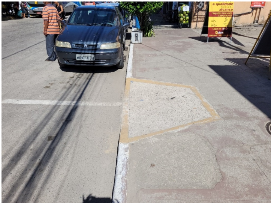
Figura 137: Rampa de acessibilidade
