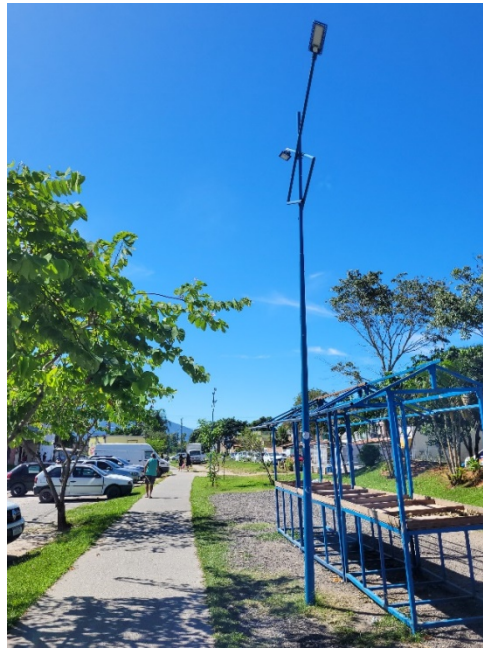
Figura 125: Iluminação pedonal na ciclovia
