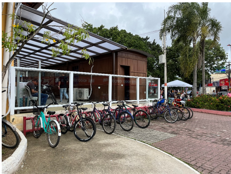
Figura 199: Paraciclo instalado ao lado do centro de informações turísticas em Maricá
