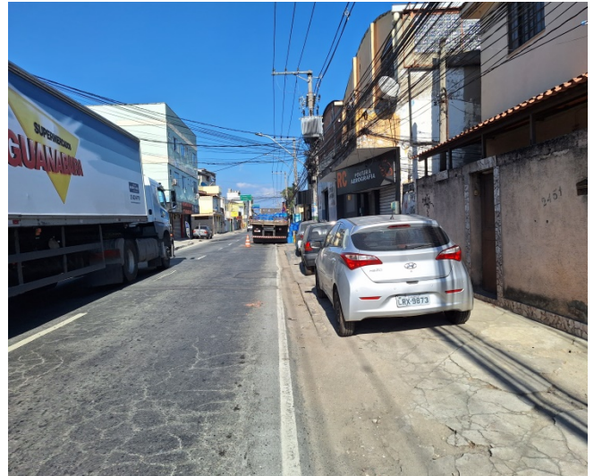
Figura 131: Calçada com largura insuficiente (obstáculos móveis)
