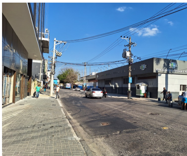
Figura 6: Calçada com boa largura e nivelada
