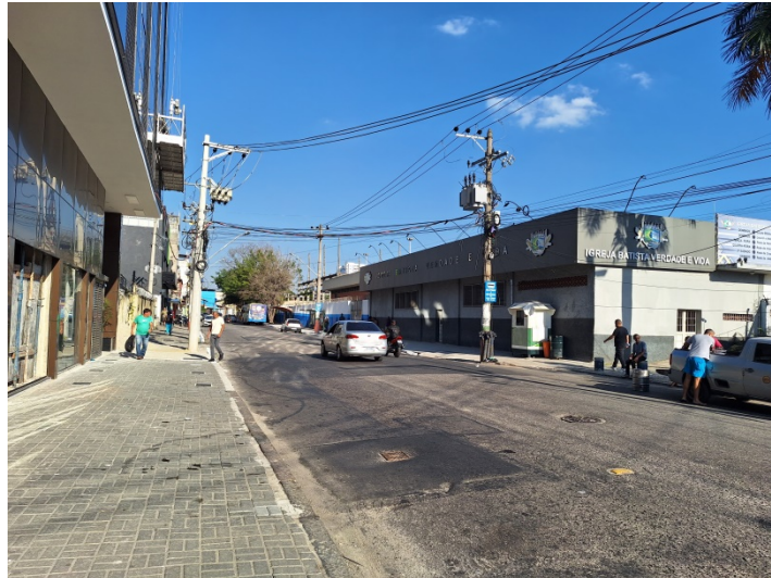
Figura 133: Calçada com boa largura e nivelada
