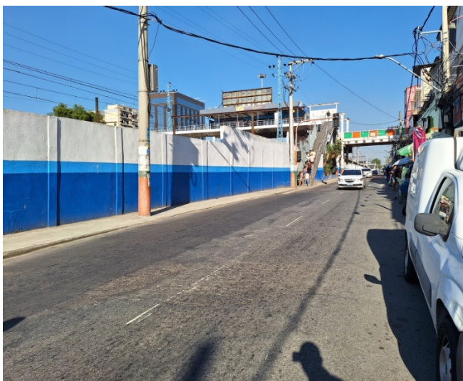
Figura 7: Barreira causada pela via férrea
