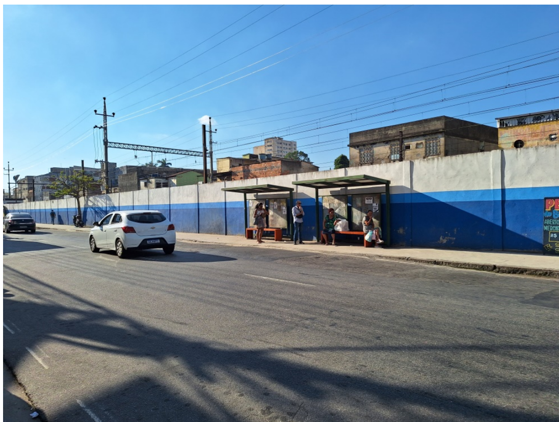
Figura 121: Pontos com abrigo junto à ferrovia
