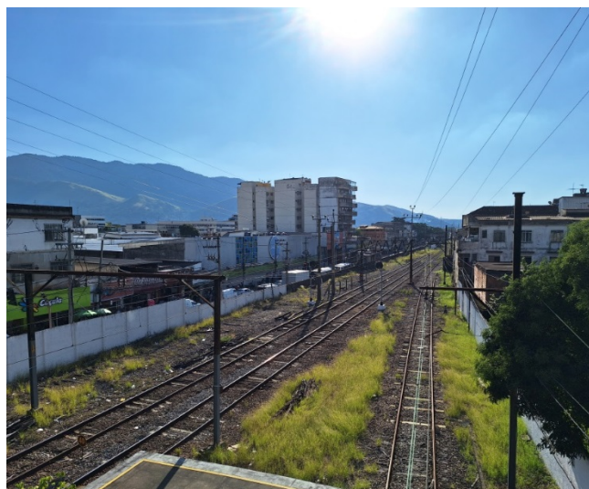
Figura 8: Barreira causada pela via férrea
