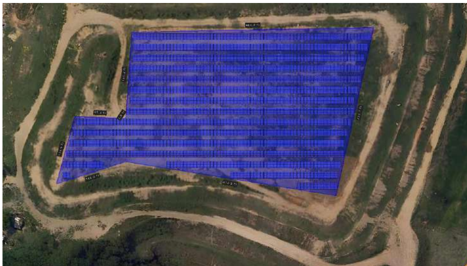
Figura 79: Usina Fotovoltaica Morro do Céu - 0,97 MW
