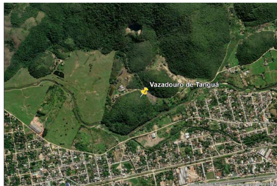
Figura 74: Imagem Aérea do Vazadouro de Tanguá
