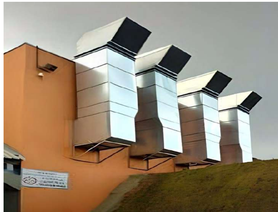
Figura 26: Sistema de Exaustão de uma ETR
