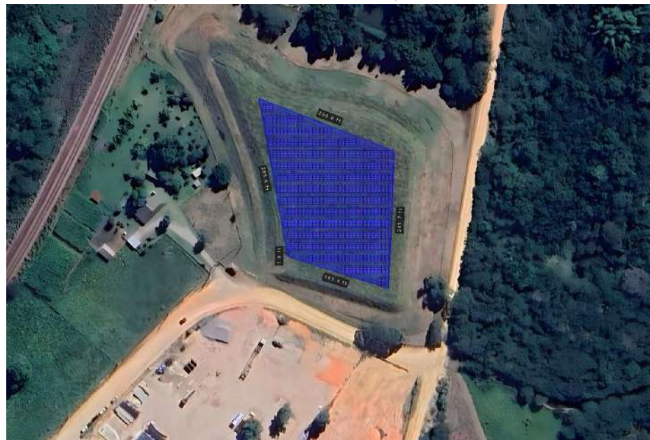
Figura 83: Usina Fotovoltaica Seropédica - 0,50 MW
