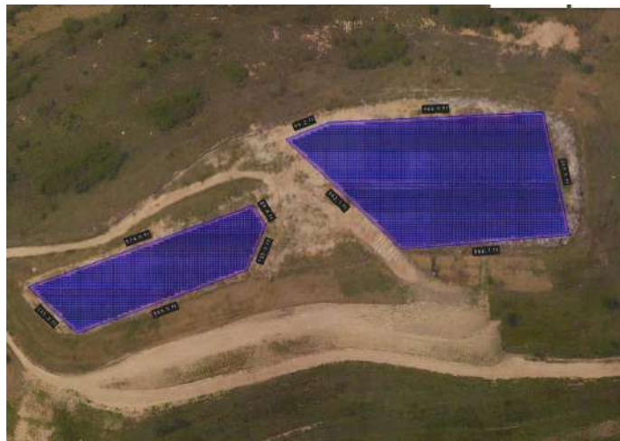
Figura 81: Usina Fotovoltaica Gericinó - 1,60 MW
