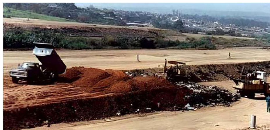
Figura 21: Aterro do RSU em Central de Tratamento de Resíduo (CTR)
