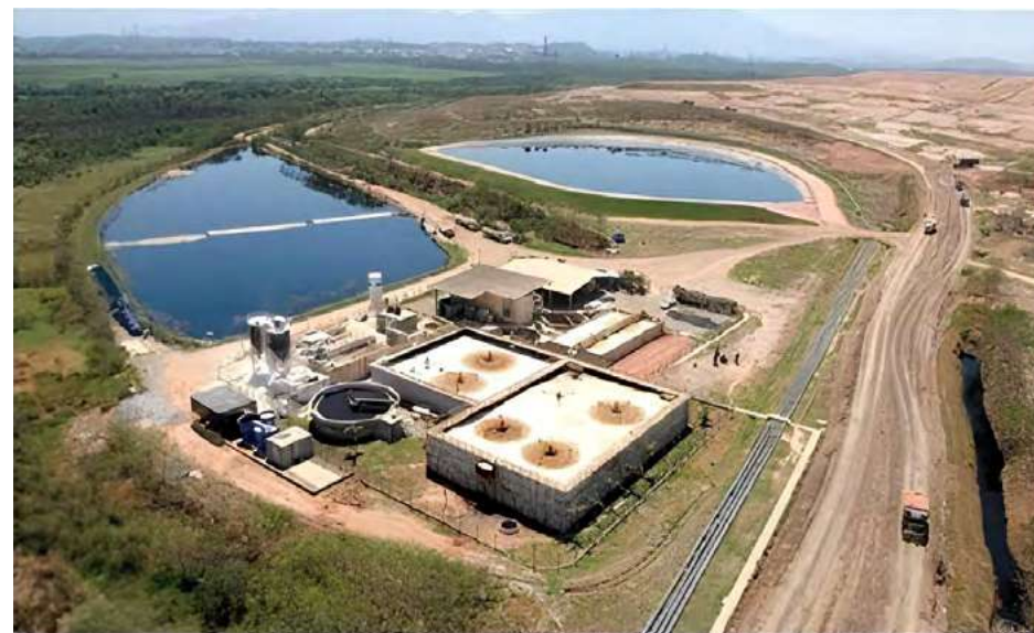
Figura 23: Vista de uma Estação de Tratamento de Chorume
