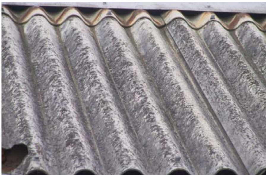
Figura 02: Telhas de Amianto (IVANA JATOBA, 2015)
