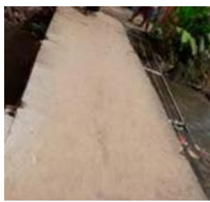
Figura 07: Ponte que liga as duas comunidades vizinhas, Praia da Rosa e Sapucaia. Imagem feita durante a visita técnica.
