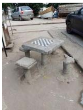
Figura 04: Banco de praça danificado, imagem feita durante a visita técnica.
