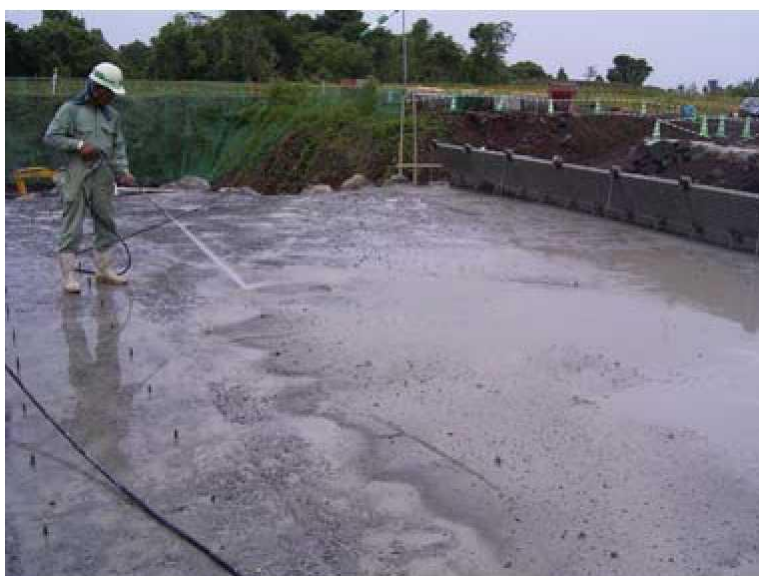
Figura 7-10 – Exemplo de corte verde com jato de água de alta pressão.
